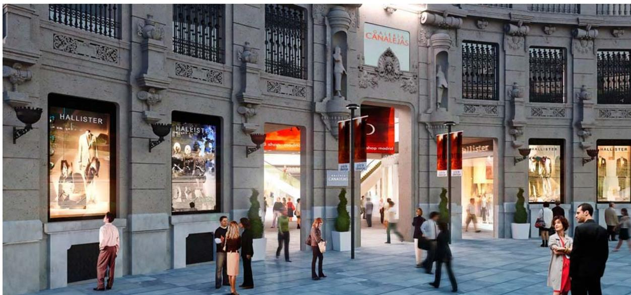
Infografía incluida en el informe del Estudio Lamela donde se aprecian las afecciones provocadas por su intervención –rasgado de huecos, rejas desplazadas del piso bajo al entresuelo- sobre la fachada hacia la plaza de Canalejas del antiguo edificio del Banco Hispano-Americano, a pesar de estar declarada BIC.
