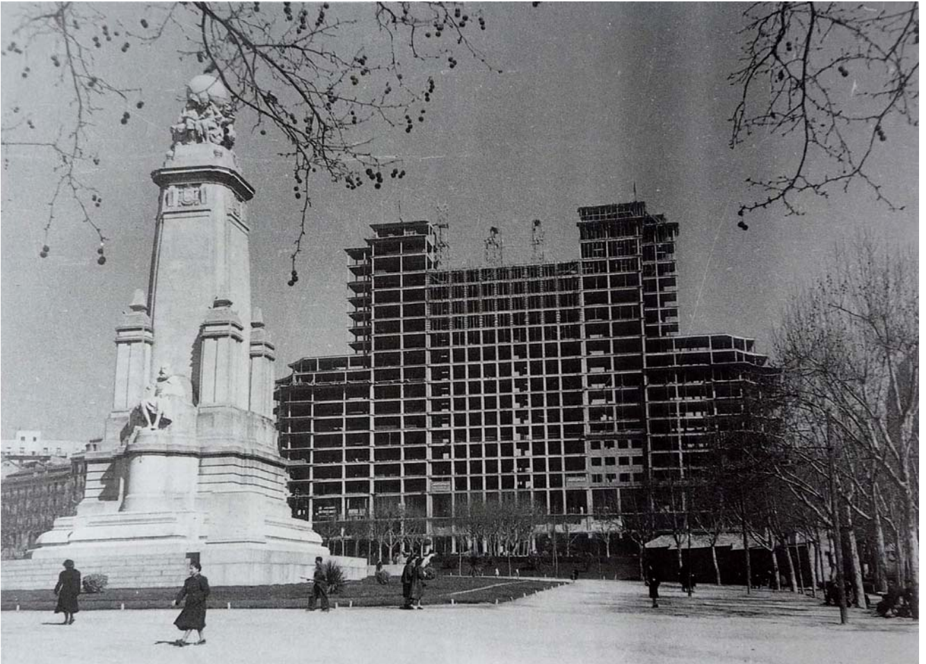
Fig. 29- La estructura del edificio España al descubierto, en 1950. Se observa la autonomía entre los diferentes volúmenes, cuya ejecución avanza a diferente velocidad.
