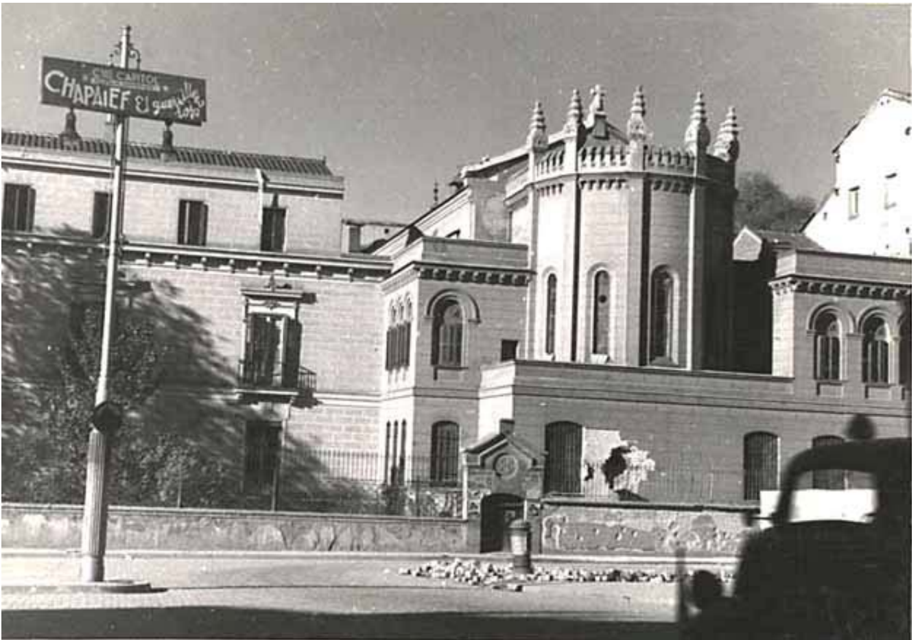
Fig. 6- El colegio del Sagrado Corazón que cerraba el paso a la prolongación de la Gran Vía, poco antes de su demolición.
