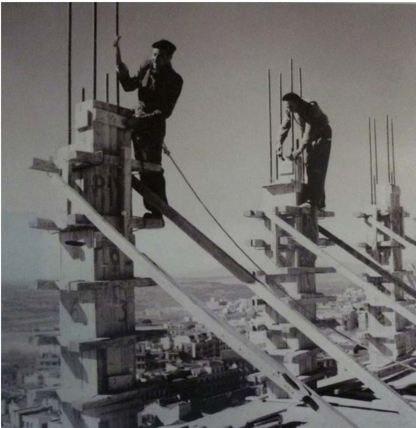
Fig. 31- Encofradores trabajando en los pilares de fachada del edificio España, hacia 1950.
