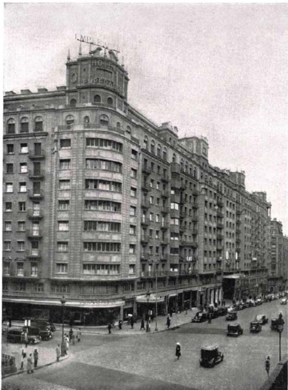
Vista de conjunto del bloque. En primer término, el chaflán a la calle de San Bernardo. (Foto L.A.R.A. Madrid.)
