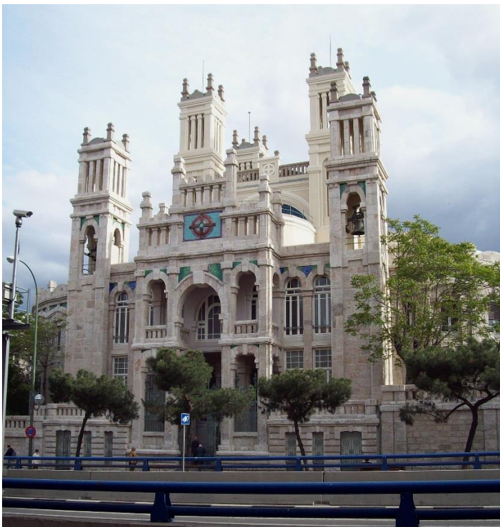
Fig.8-Hospital de Jornaleros de San Francisco de Paula. Terminado un año antes y distante apenas 300 metros de Cuatro Caminos. Las numerosas similitudes entre ambas obras refuerzan la tesis de la autoría de Antonio Palacios
