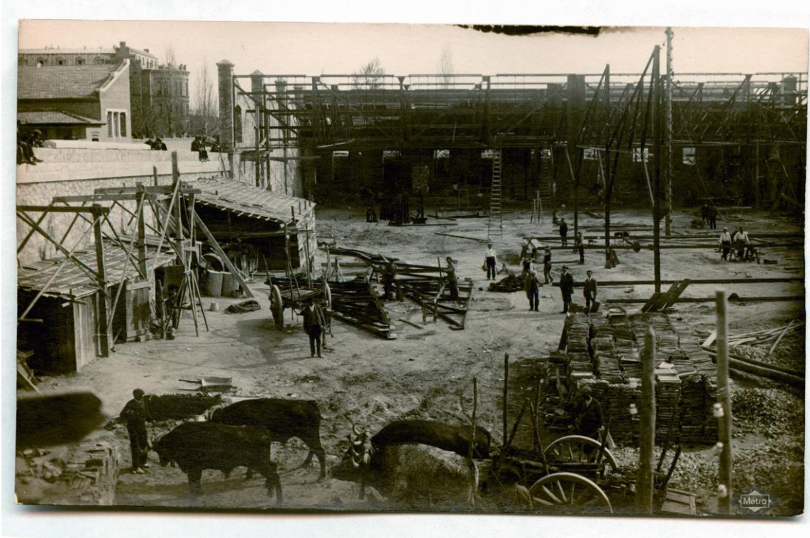
Figs 20 y 21.-Construcción de las naves A y B, 1919. Montaje de la estructura metálica de las cocheras. La más moderna tecnología convive con los tiros de bueyes. Los acopios de ladrillos y traviesas nos indican el papel de Cuatro Caminos como centro logístico de las obras. Nótese los viandantes asomados al pretil en la esquina izquierda de ambas foto, lo que indica la voluntad por parte del proyectista de incorporar el edificio a la escena urbana. Archivo Metro
