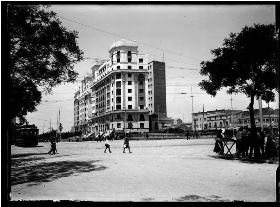
Fig.28-El edificio Titanic poco después de su construcción. Obsérvese el contraste producido por la nueva escala introducida.
