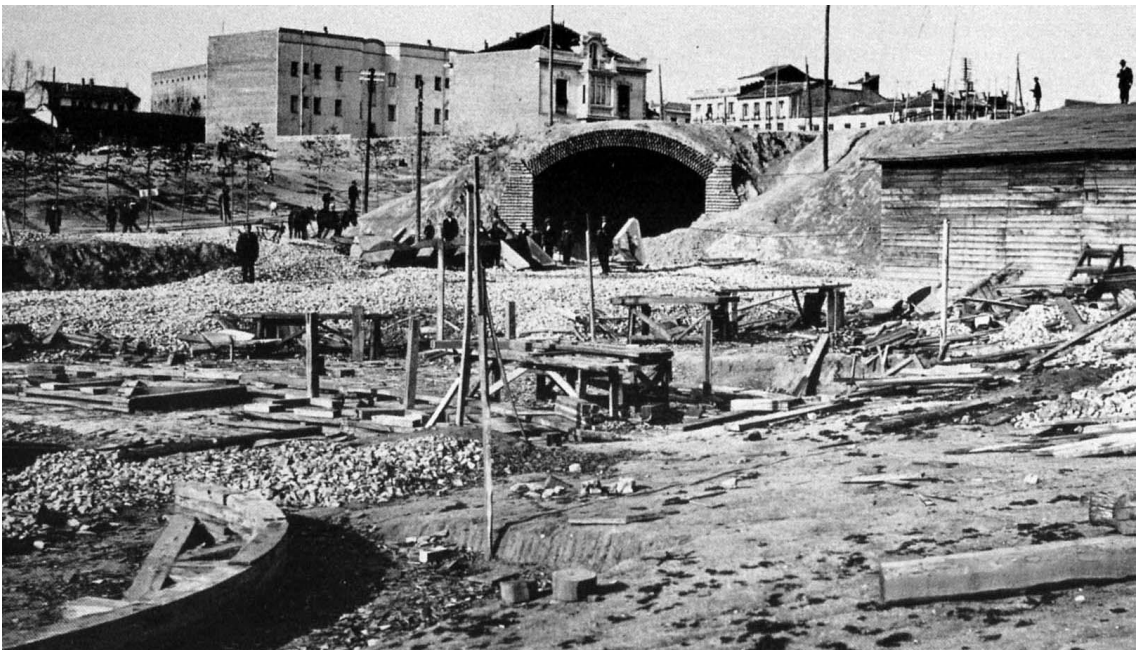
Fig.14- Salida del túnel a los talleres del paseo de ronda, 30 de Abril de 1918. En primer plano las cimbras empleadas para entibar los túneles. Las casas situadas en el centro de la foto serán derribadas para construir los edificios Titanic. Foto publicada en el libro Metropolitano Alfonso XIII , 1921
