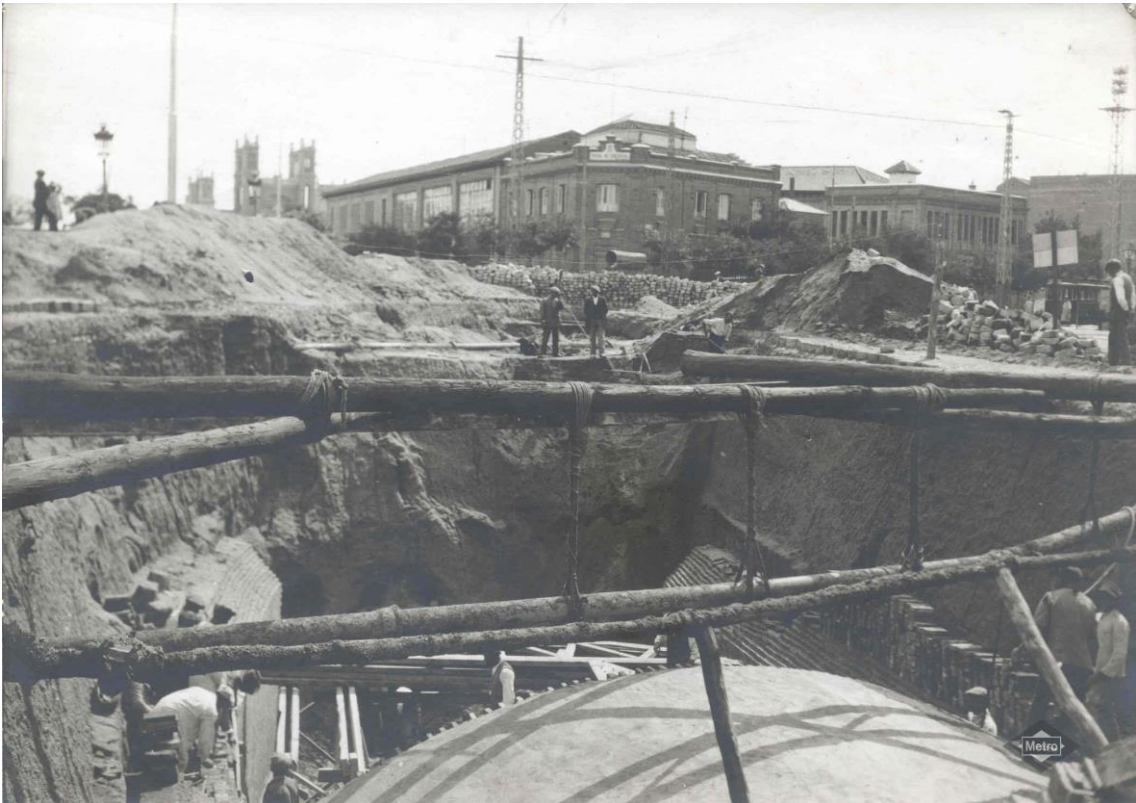
Fig.13-Excavación del túnel en zanja abierta en Cuatro Caminos. En primer plano, las canalizaciones descubiertas por la excavación de la galería. Al fondo se aprecia la Casa de Socorro de Cuatro Caminos, las Escuelas Cervantes y el inconfundible perfil del Hospital de Maudes. Archivo Metro
