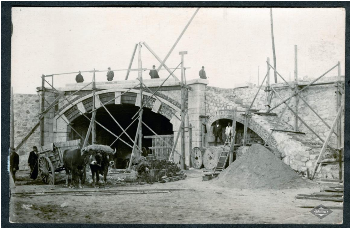
Figs15 y 16- Boquilla del túnel en construcción (1919) y terminada (1921). Antonio Palacios diseña una escalinata que monumentaliza el acceso desde la avenida de la Reina Victoria, por entonces en pleno desarrollo urbano. Nótese la elaborada reja y los postes de catenaria de hormigón, que siguen aún formas heredadas de las estructuras metálicas. Archivo Metro y foto publicada en el libro Metropolitano Alfonso XIII , 1921
