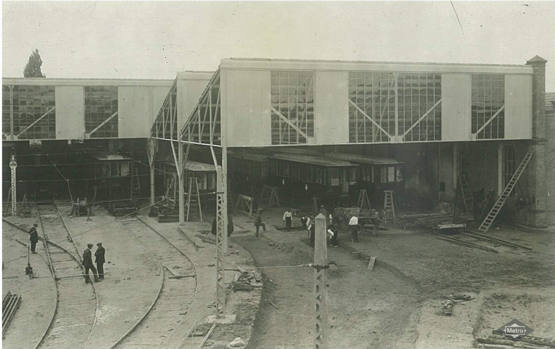
Figs.22 y 23. Las naves A y B de las cocheras en la última fase de construcción de la línea, 1919. El edificio ya se emplea como cochera a pesar de no estar terminado el tendido de la vía. Esta pareja de fotos tomadas sucesivamente muestran un encuadre recurrente con pequeñas variaciones, lo que no puede ser casual. Con el recurso al retranqueo de la nave A se puede percibir la ligereza de la estructura, y se potencia un eje visual en diagonal, que convierte al edificio en telón de fondo de la playa de vías. Archivo Metro
