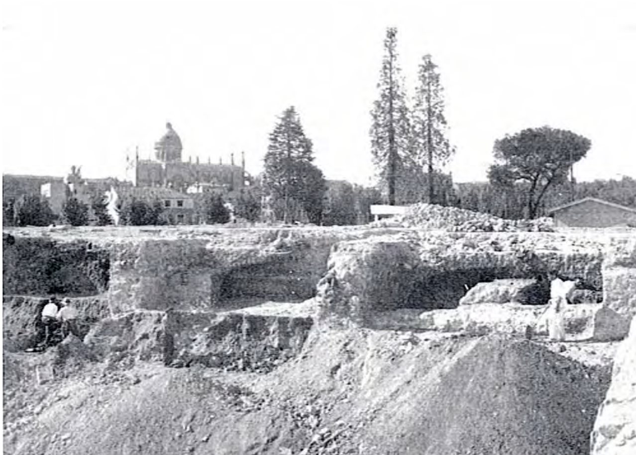
Fig. 148 – Trabajos de demolición de las Caballerizas Reales en enero de 1935.
