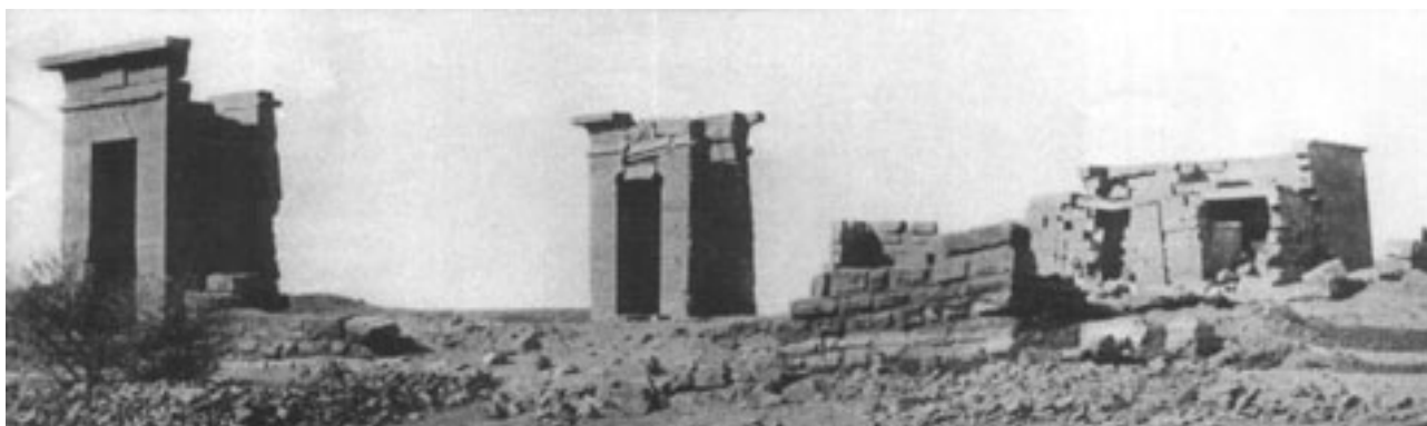
Fig. 220- El templo de Debod en 1919, con sólo dos puertas y la capilla completamente arruinada.
