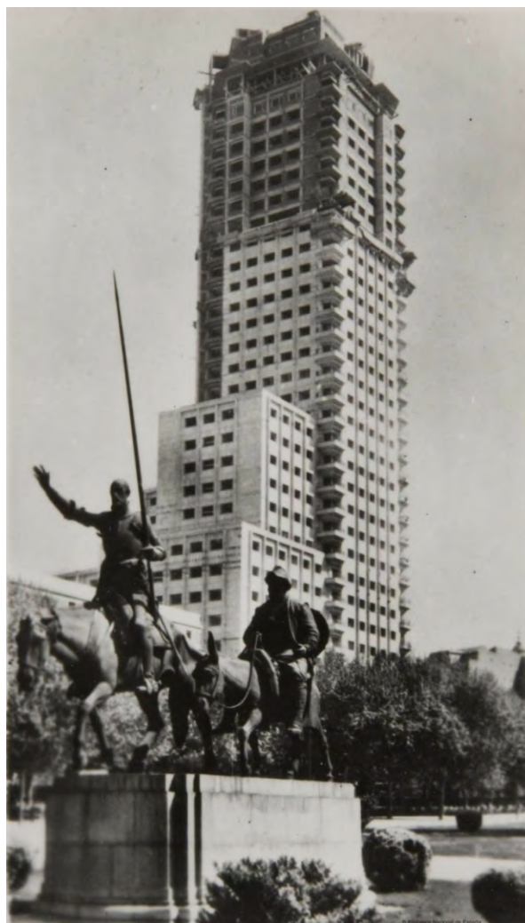
Fig. 196- Vista de la Torre de Madrid en construcción, con el grupo escultórico de Don Quijote y Sancho Panza en primer plano. Heliotipia Artística Española, 1959.
