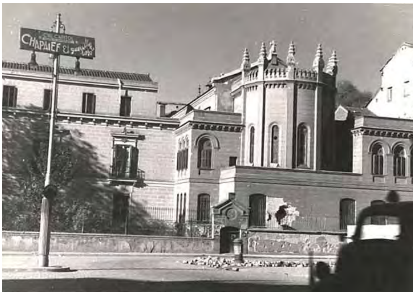
Fig. 157- El colegio del Sagrado Corazón que cerraba el paso a la prolongación de la Gran Vía, poco antes de su demolición.
