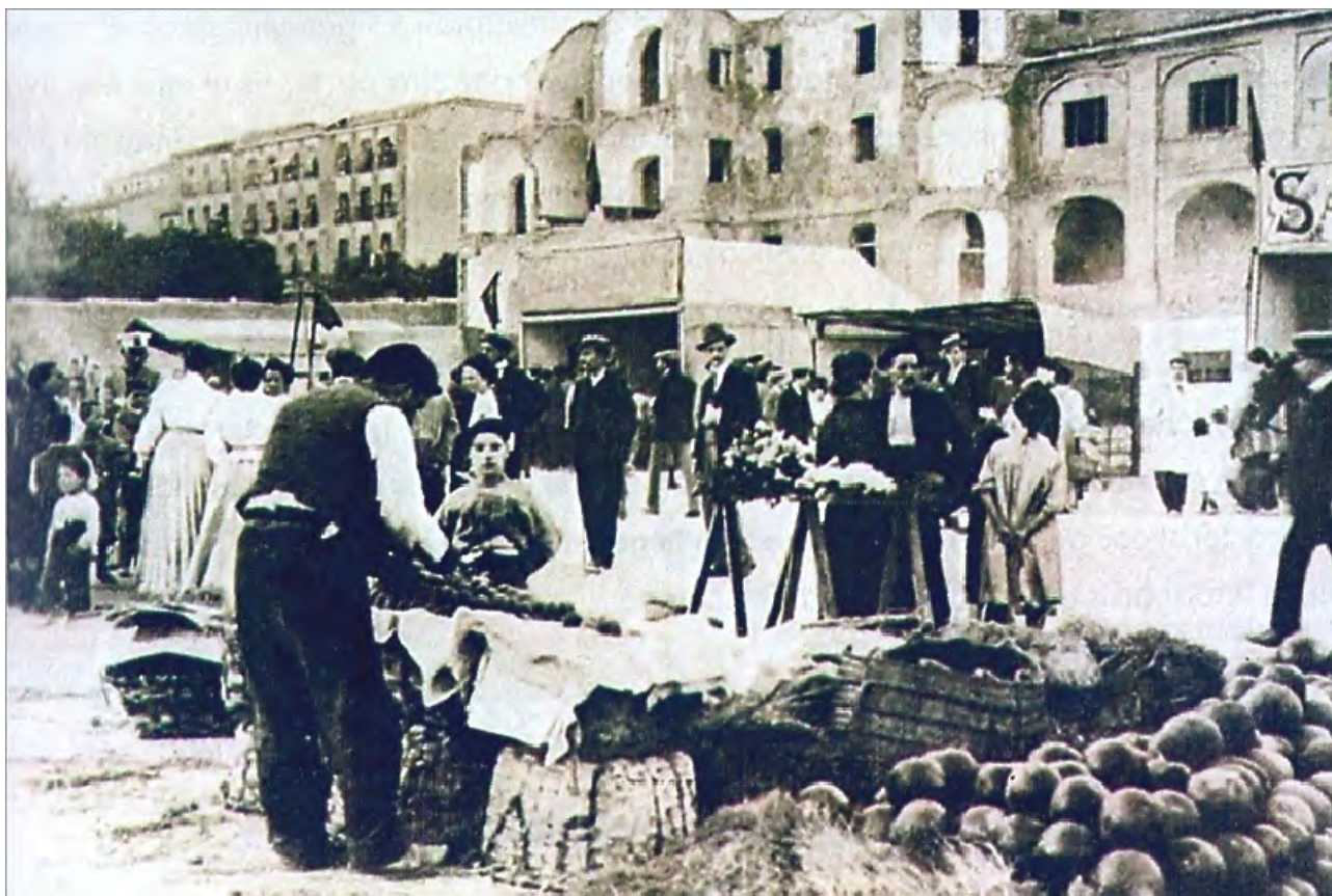
Fig. 58- Solar del Cuartel de San Gil en 1907. Al fondo se observa parte del edificio a medio derribar.
