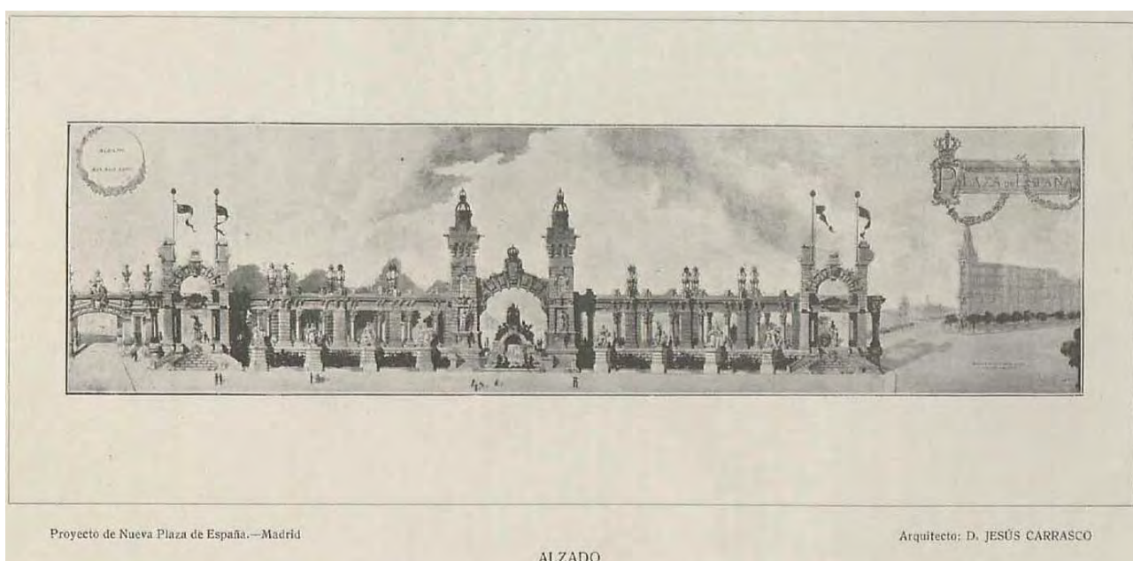
Fig. 65- Alzado del pórtico que resuelve el desnivel de la nueva Plaza de España con la calle de Leganitos, 1910. Arquitecto: Jesús Carrasco Muñoz-Encina. Arquitectura y construcción . Año XV, nº 224, marzo 1911.
