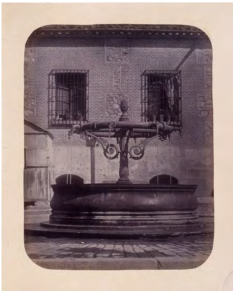
Fig. 24- Fuente de fundición de hierro de "ocho caños" en la plazuela de la Encarnación, 1864. Fotografía: Alfonso Begué.
