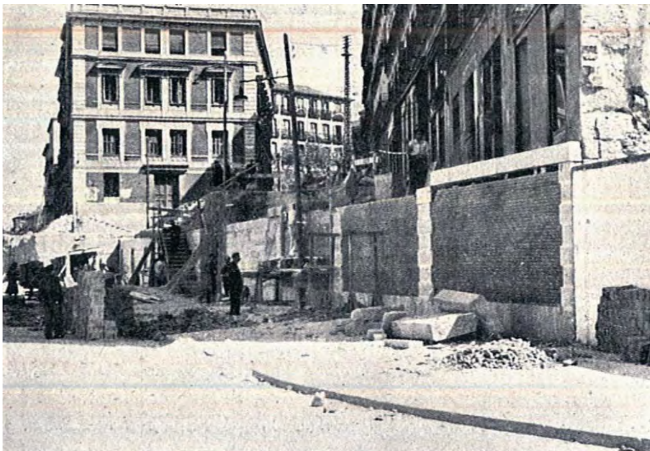
Fig. 167- Construcción de muros de contención para resolver el desnivel de los edificios existentes con la nueva rasante de la calle de la Princesa; a la izquierda, la Casa de Socorro.
