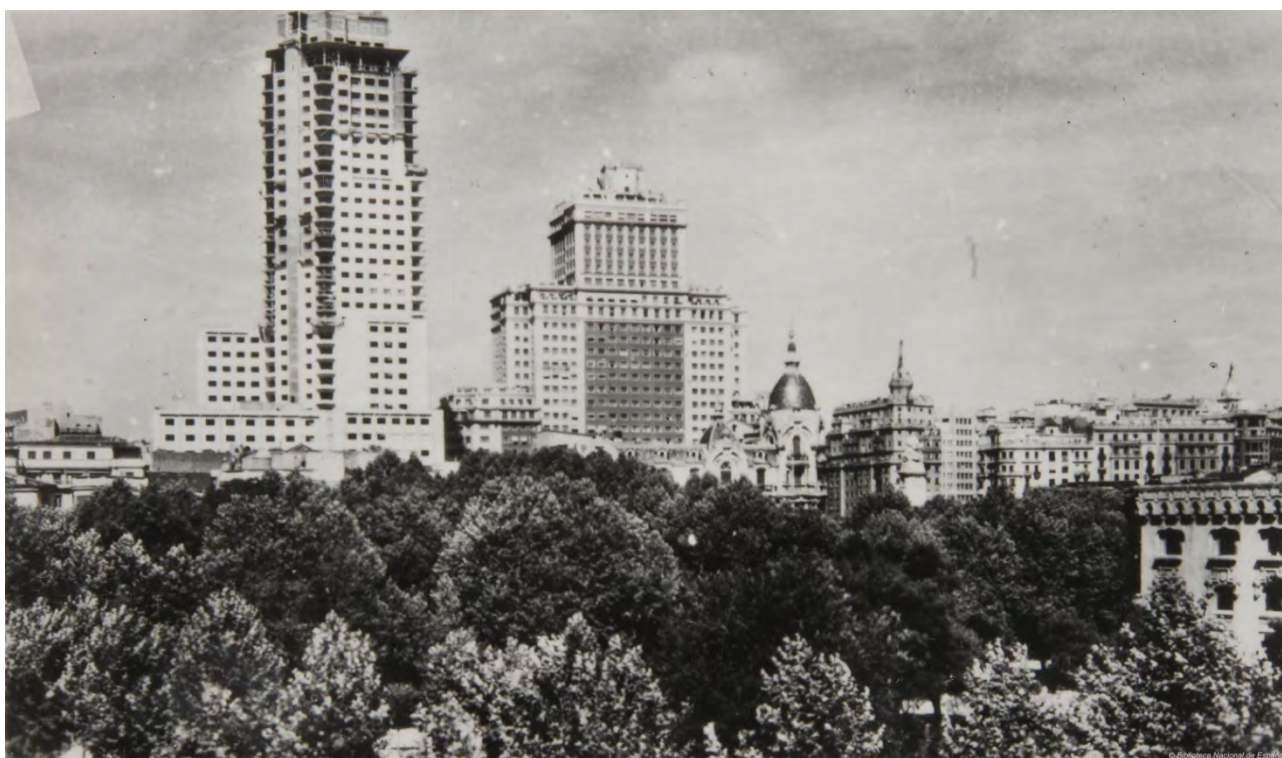
Fig. 197- Vista general de la Torre de Madrid en construcción y del Edificio España desde los jardines de Ferraz. Heliotipia Artística Española, 1959.
