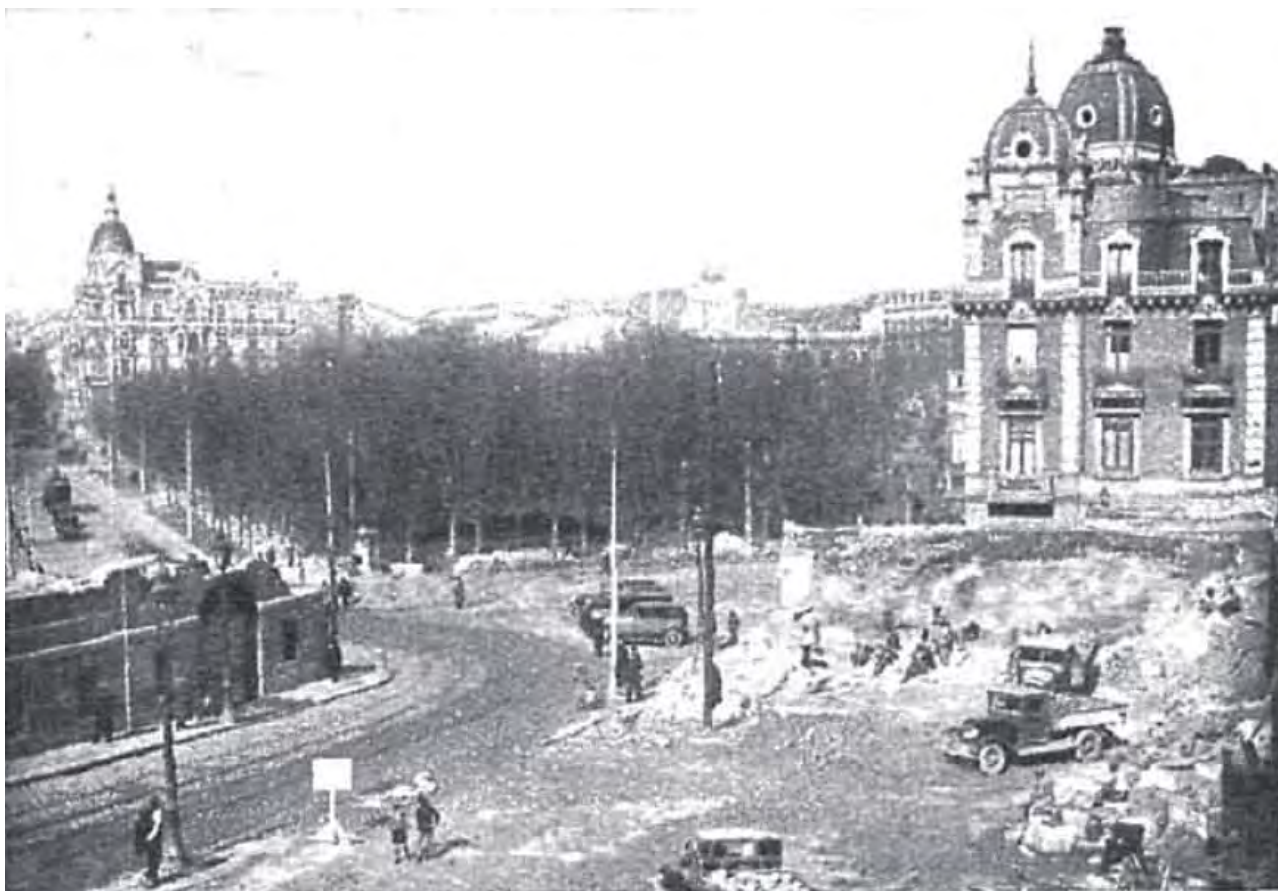
Fig. 146. Trabajos simultáneos de ensanche de la calle de Bailén y de derribo de las Caballerizas Reales, con la plaza de España al fondo. Nuevo Mundo , Año XXXX, nº 2.031, 10 de febrero de 1933.
