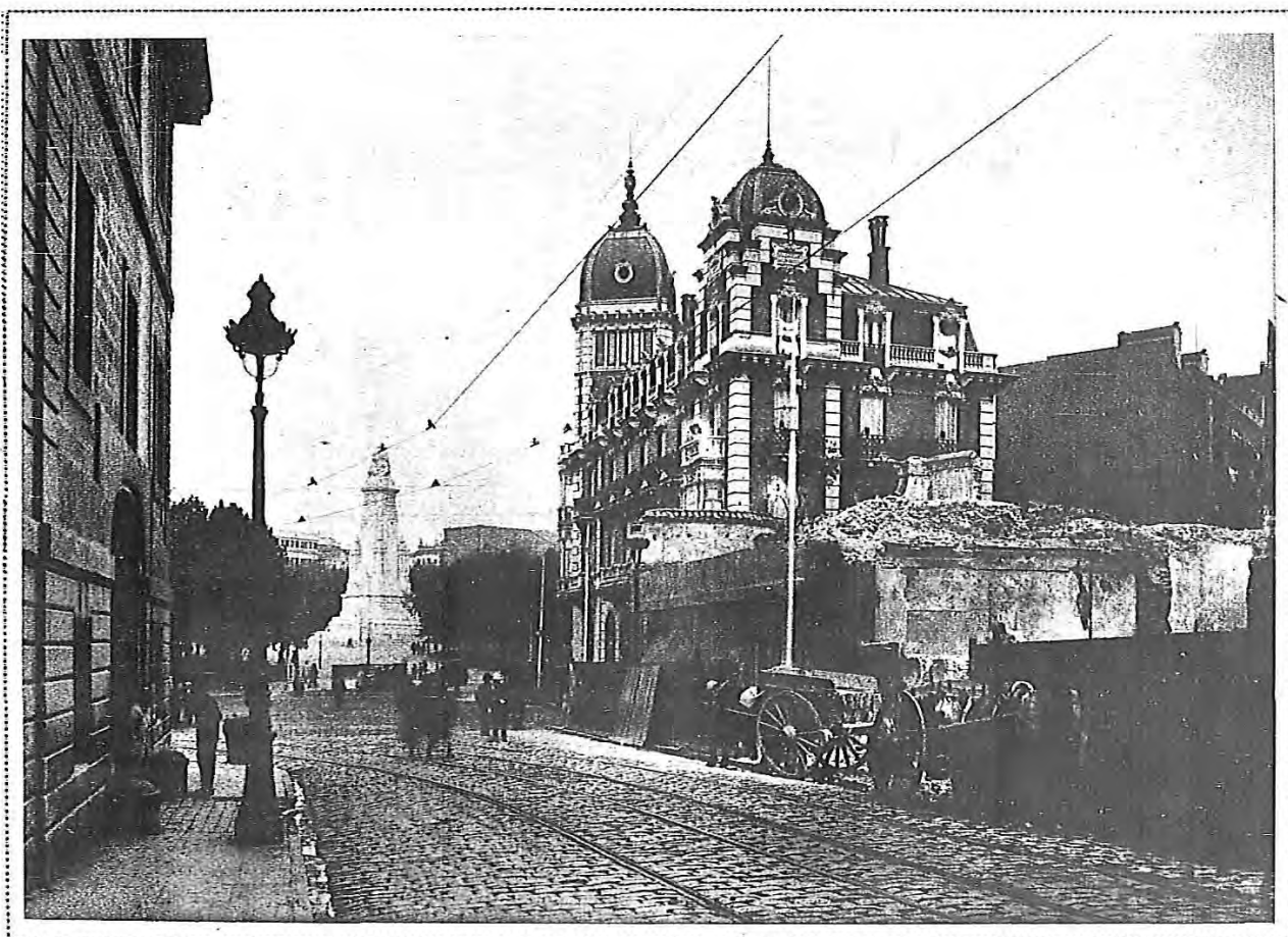
Calle de Bailén en su desembocadura a la Plaza de España, que deberá ensancharse tal como la concebían los concejales de 1912
