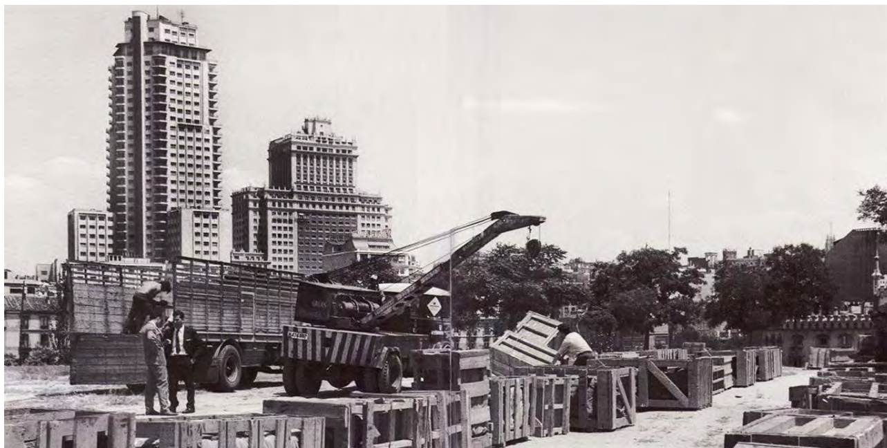
Fig. 221- Descarga del primer lote de sillares del Templo de Debod, el 20 de junio de 1970.
