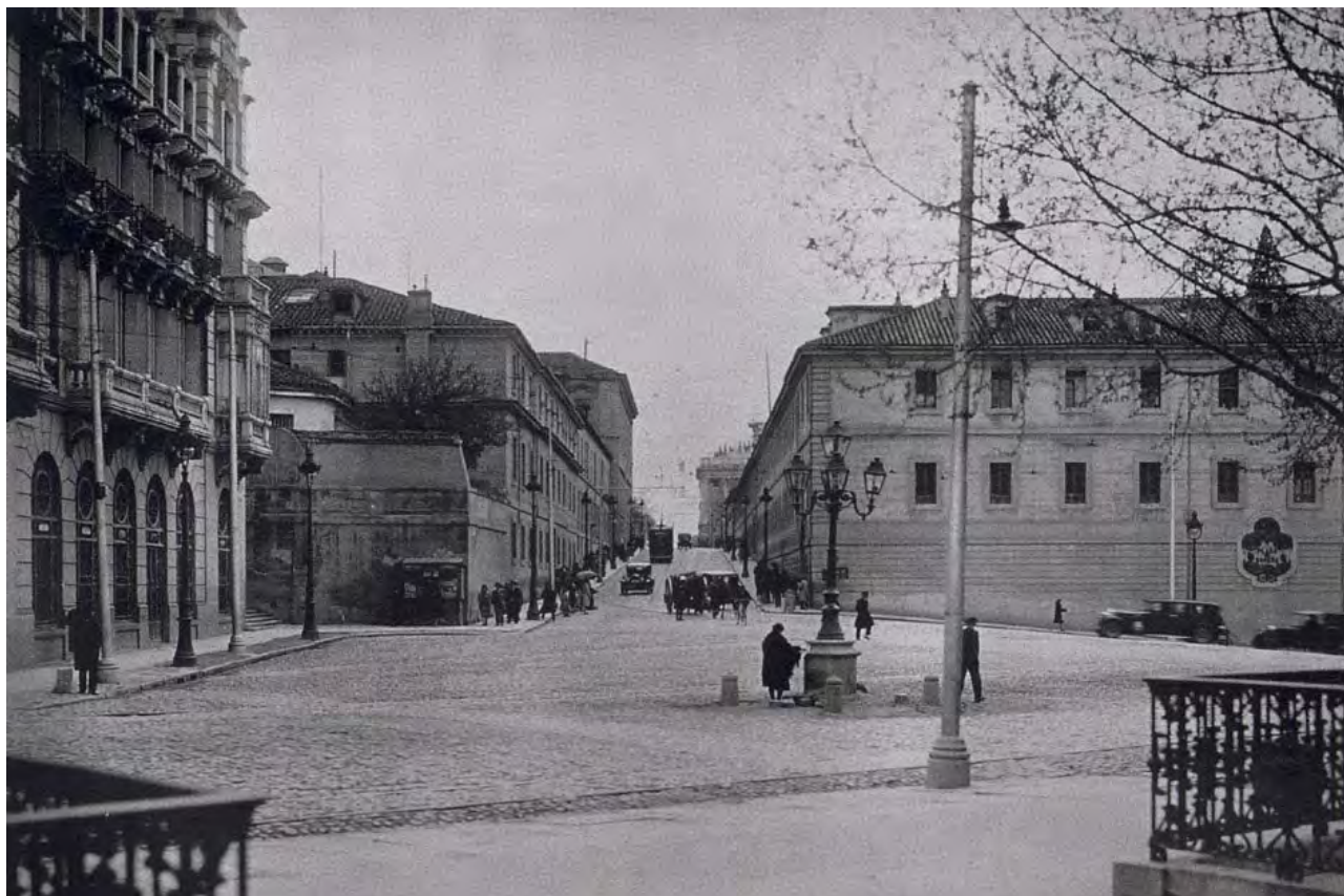
Fig. 132- La calle de Bailén antes de ensancharse en una fotografía fechada hacia 1920. A la izquierda se aprecia como el edificio de la Real Compañía asturiana de Minas se adecúa ya a la nueva alineación.
