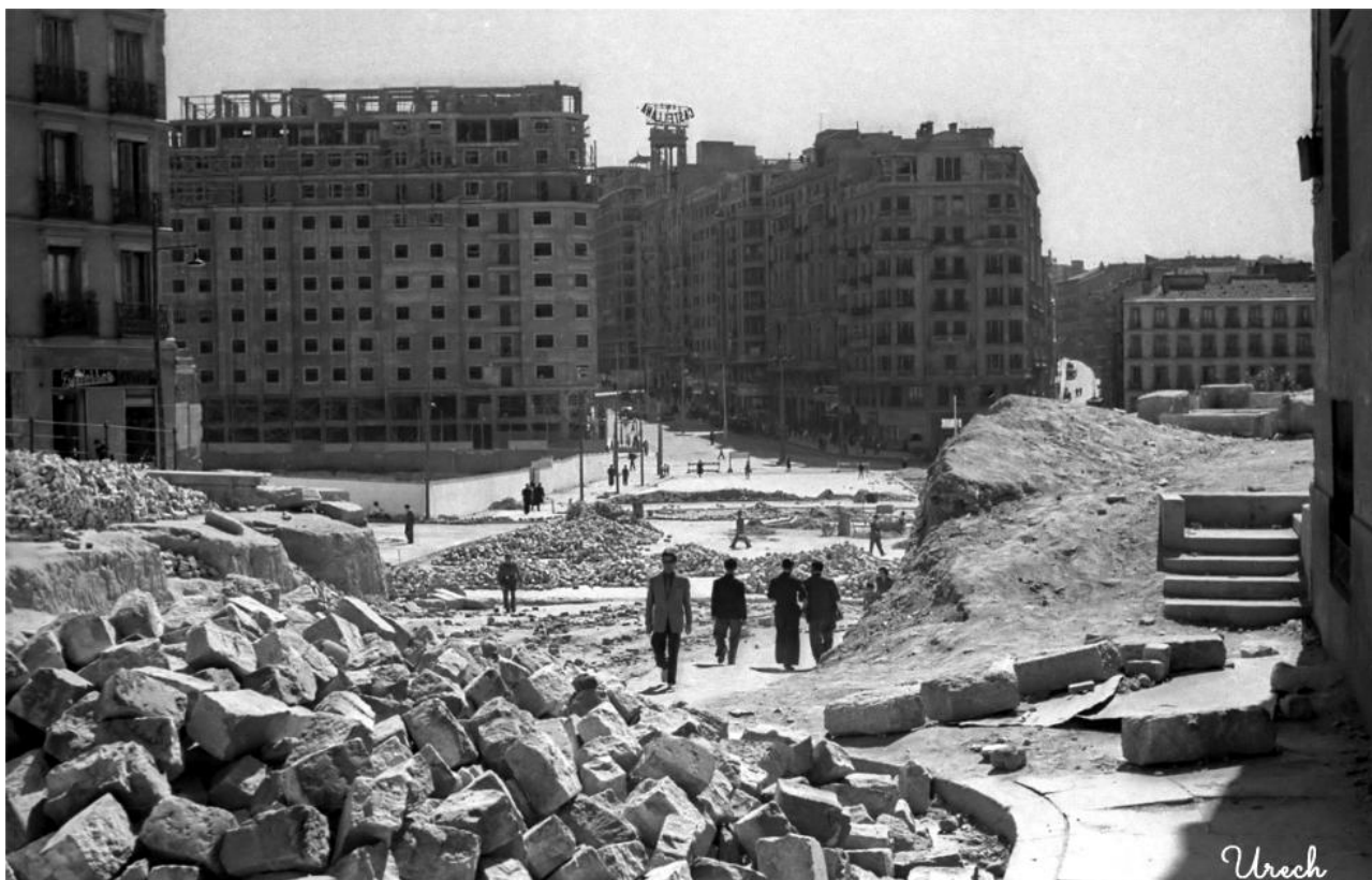
Fig. 172- Otra vista de las obras con el último edificio de la acera de los pares de la Gran Vía ya en construcción. Fotografía de Manuel Urech, de hacia 1946.
