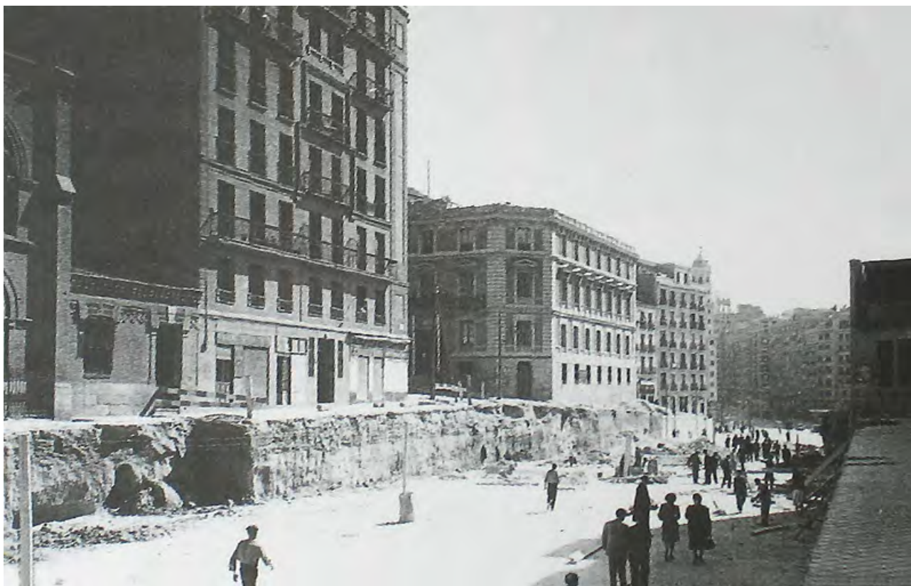
Fig. 165- Calle de la Princesa tras iniciarse los desmontes para corregir su rasante: en primer plano a la izquierda puede verse un trozo de "La Cara de Dios"; en el centro, la Casa de Socorro del Distrito de Palacio.
