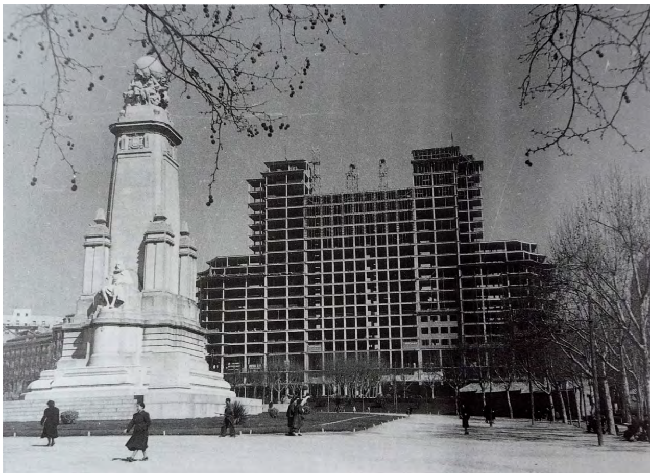
Fig. 183- La estructura del edificio España al descubierto, en 1950. Se observa la autonomía entre los diferentes volúmenes, cuya ejecución avanza a diferente velocidad.
