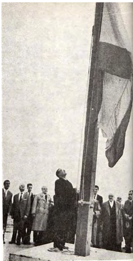
El teniente de Alcalde, Sr. Soler Díaz-Guijarro, iza la bandera en la última planta del nuevo edificio llamado Torre de Madrid.
