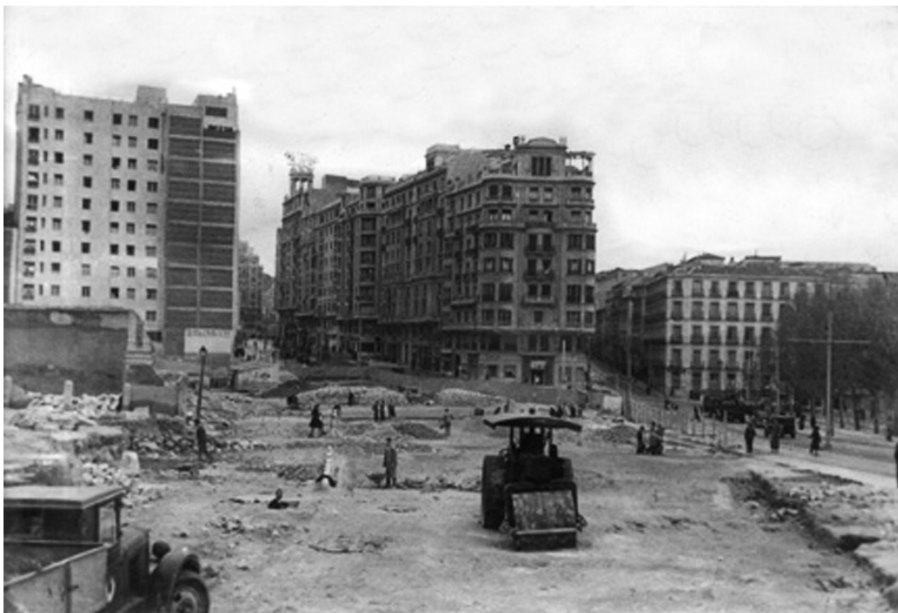
Fig. 163- Apertura de la comunicación entre la Gran Vía y la calle Princesa. Foto anónima, hacia 1943.
