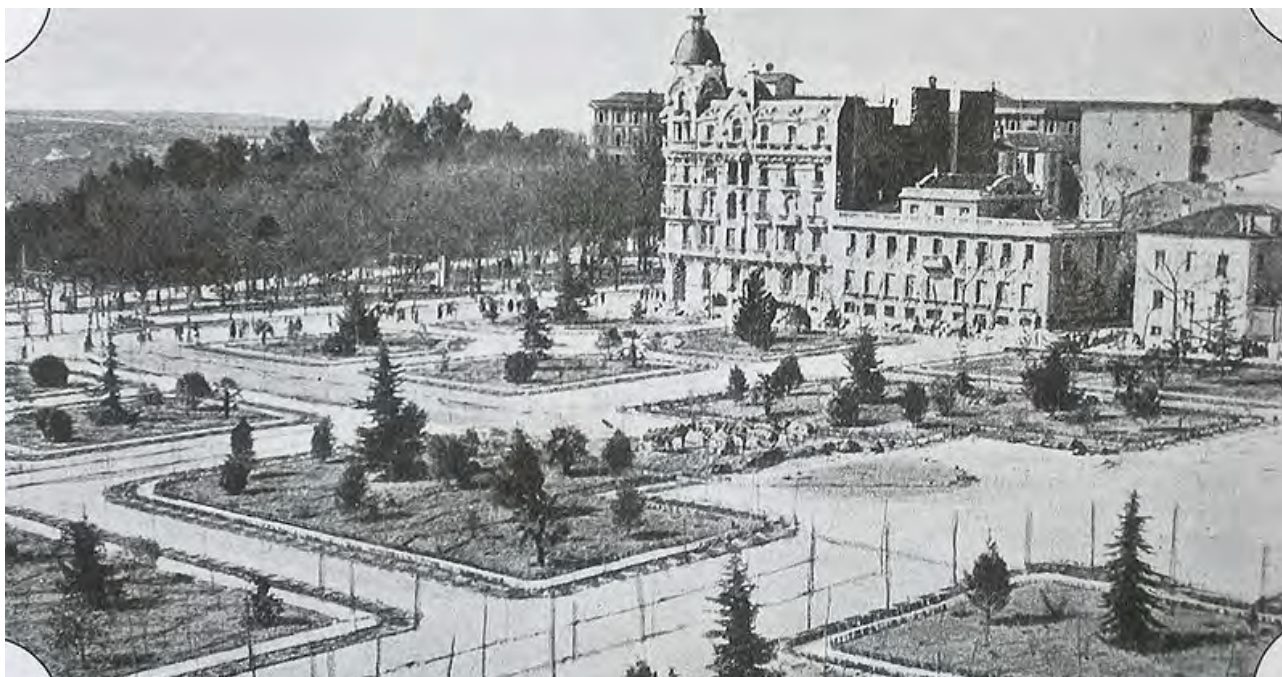
Fig. 101— Otra imagen de la plaza de España en 1918, con las plantaciones recién ejecutadas. A la derecha puede verse el vacío previsto para acoger el monumento a Cervantes, y al fondo la Casa Gallardo, recientemente terminada.
