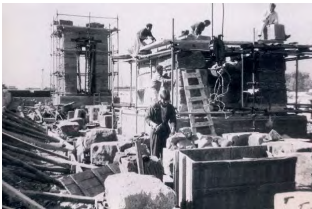
Fig. 222- Trabajos de montaje del Templo de Debod.
