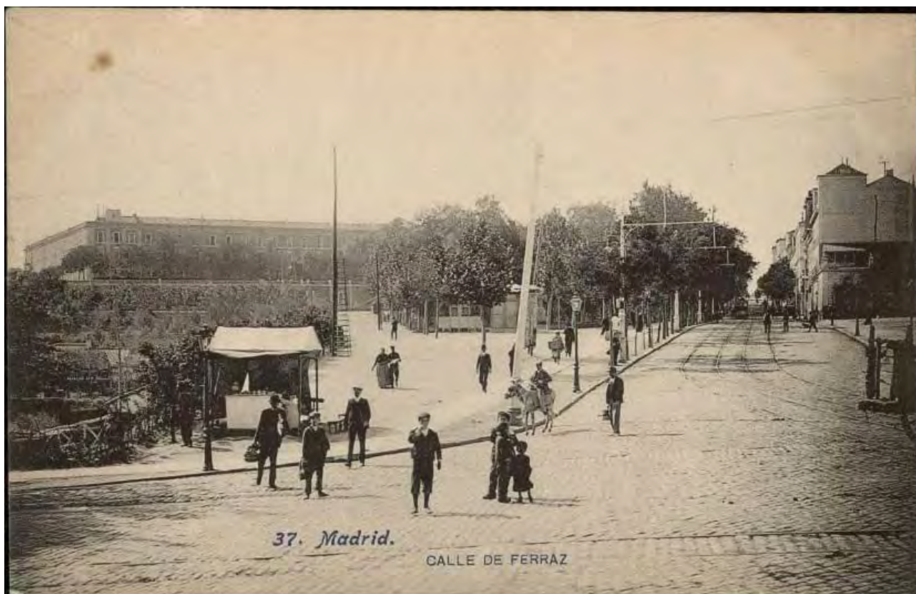
Fig. 59- Esta postal recoge el mismo punto de vista que la fig. 34, pero con el cuartel de San Gil ya demolido.
