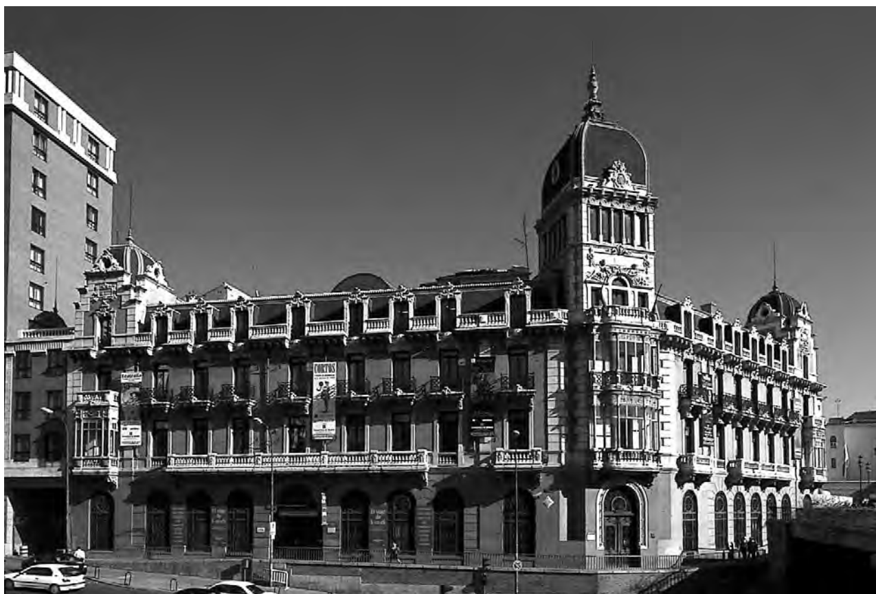
Fig. 212- El edificio de la Real Compañía Asturiana de minas en la confusa posición a que le condena el paso mixto elevado y subterráneo de Ferraz-Bailén-cuesta de San Vicente-plaza de España.
