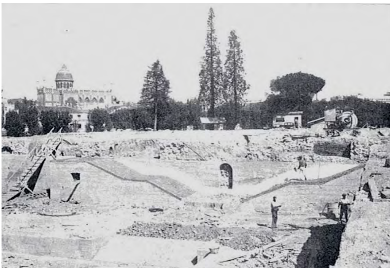
Fig. 149– Trabajos de construcción de los Jardines de Sabatini a 25 de septiembre de 1935.
