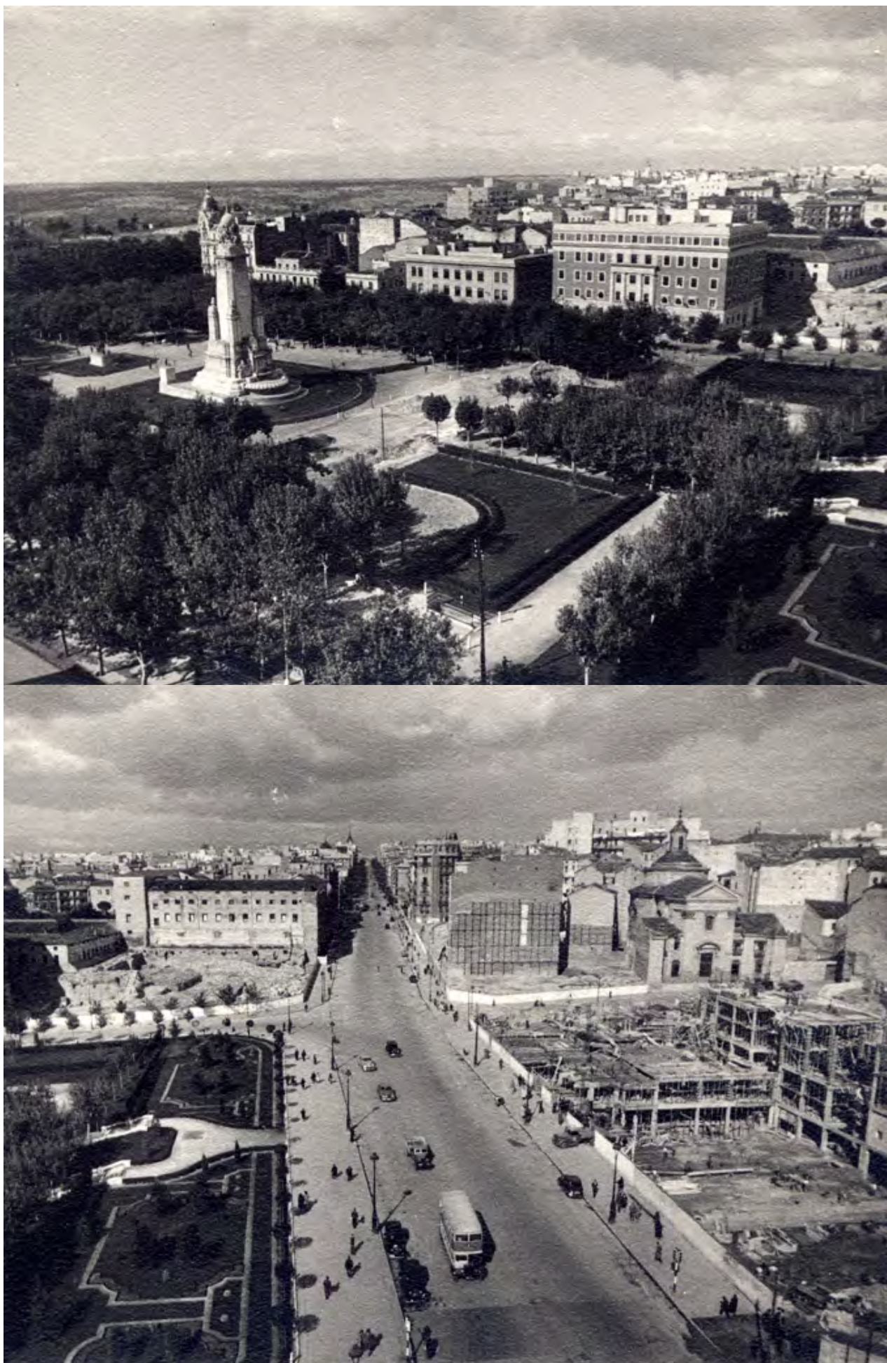
Fig. 182- Vista de la recién ajardinada plaza de España con el arranque de las obras del inmueble homónimo en 1948.
