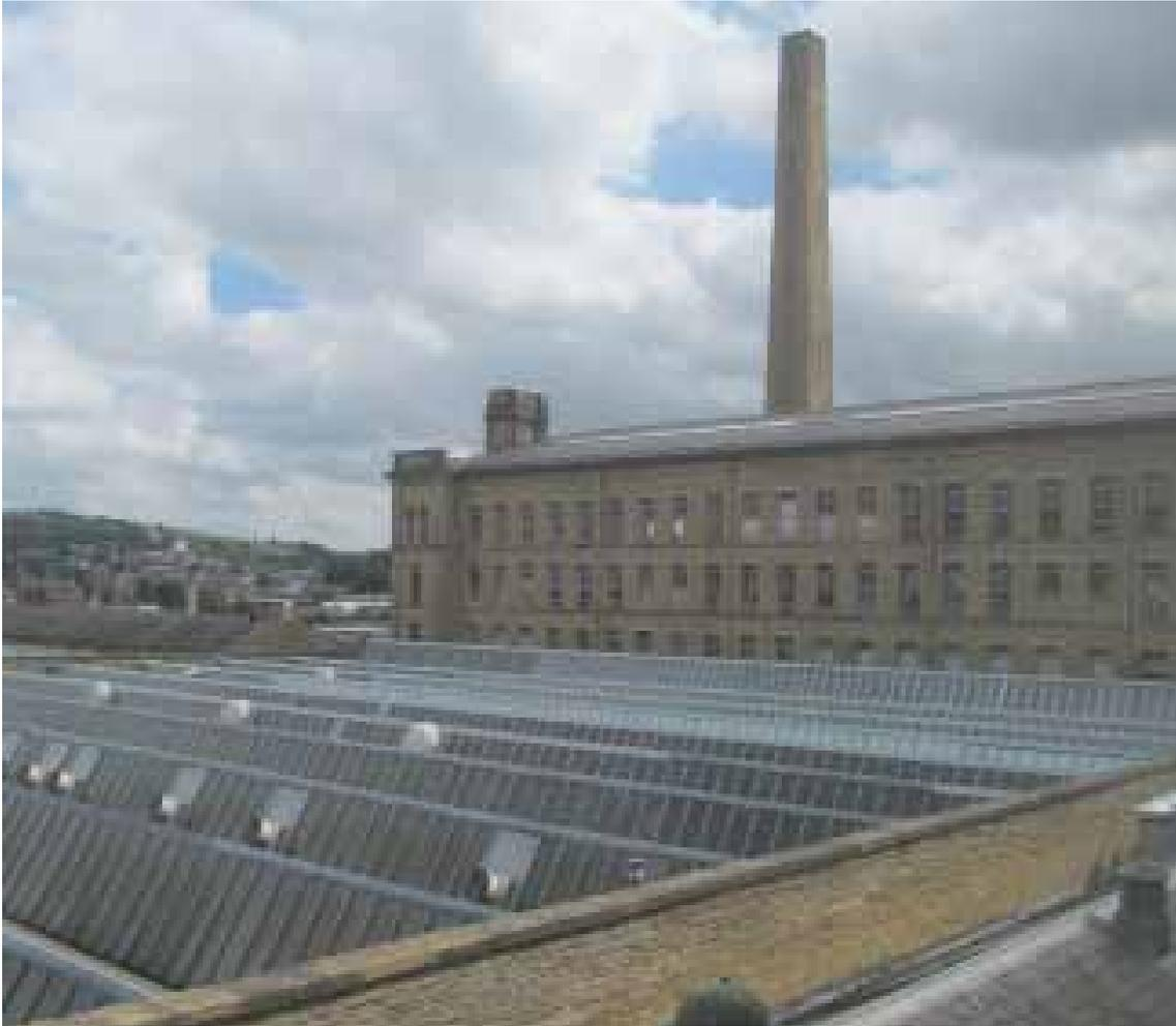
Figs.6.6 y 6.7- La viga-lucernario es el resultado de la combinación del sistema de iluminación en *shed* con las vigas metálicas en celosía, desarrolladas al calor del auge de la construcción ferroviaria. *Weaving shed, Saltaire Mills, Bradford* (1851) y Viaducto de Santa Ana en Benissa (1911-15). Álvaro Valdés y Daniel García
