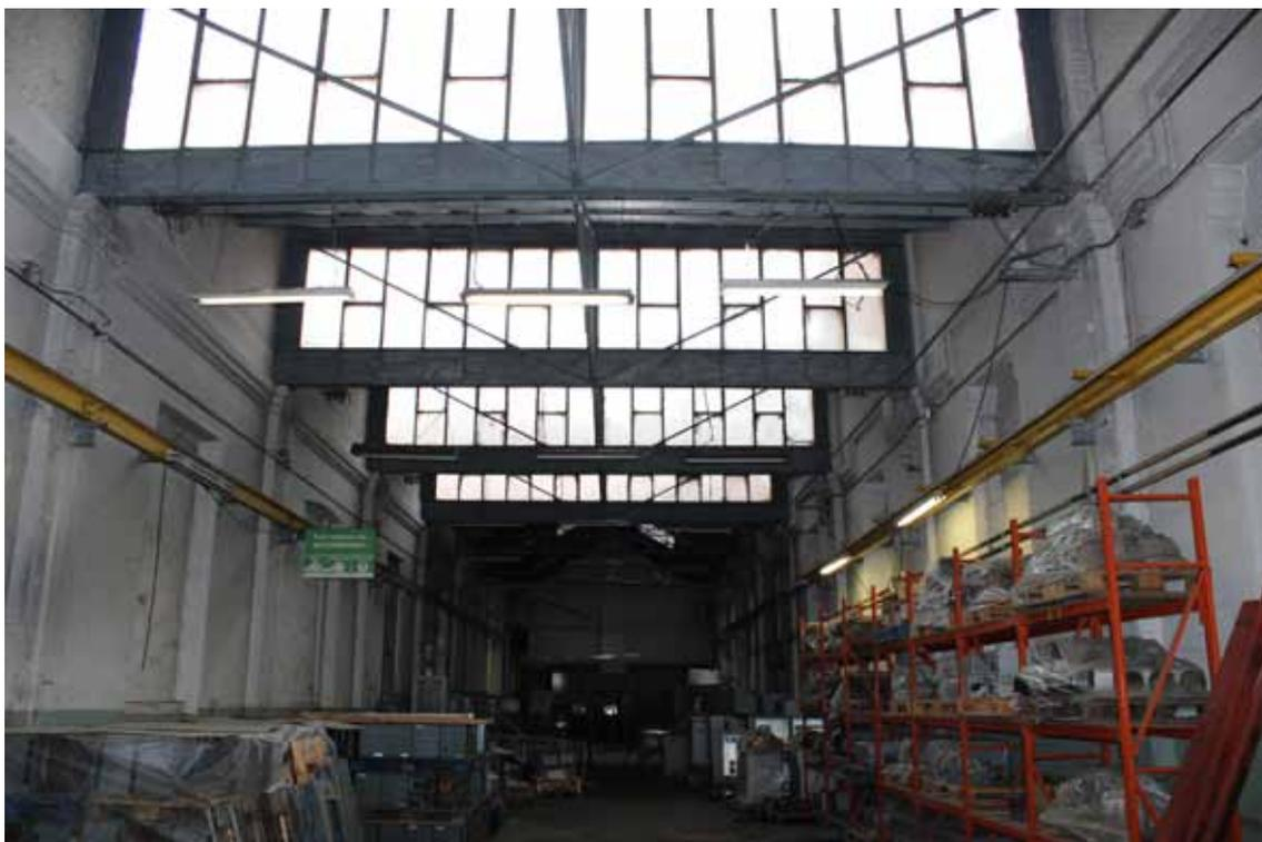
Figs.V.10- Interior de la *Nave C* (1919) con los lucernarios contruídos para sustituir su cubierta original de teja plana a dos aguas. A remarcar el revocado de los muros. Antonio Manuel Sanz
