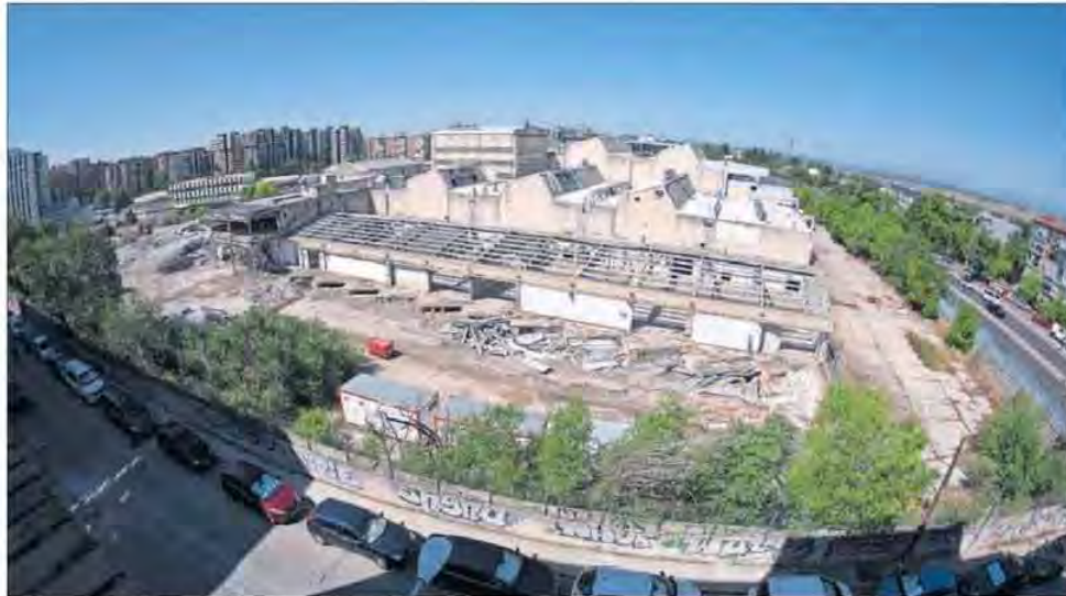
Vista panorámica de la antigua fábrica de Clesa el pasado 30 de julio. / IMAA FLORES
