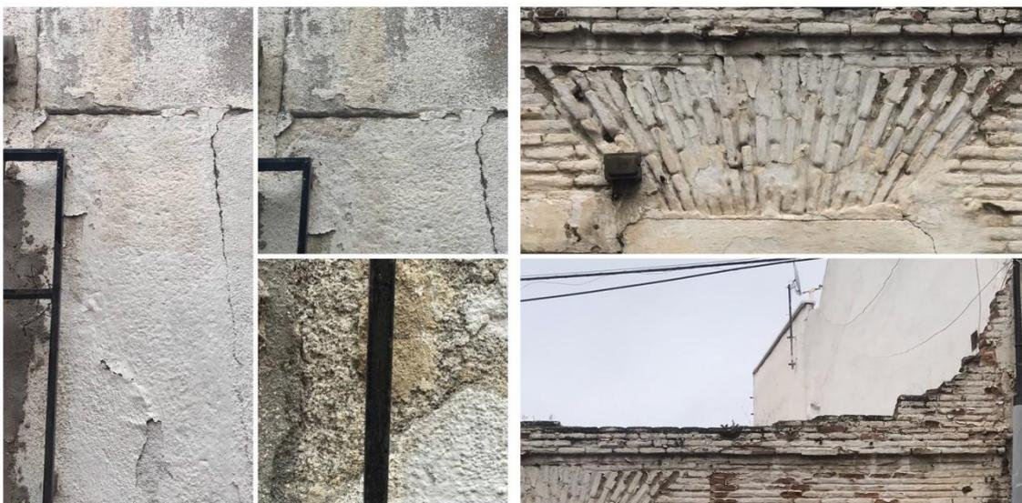
Figura 10. Imágenes de detalle de un pilar de granito sobre el que se apoya el dintel e imágenes del remate del dintel de la ventana y decoración longitudinal con ladrillos sobresalientes.
