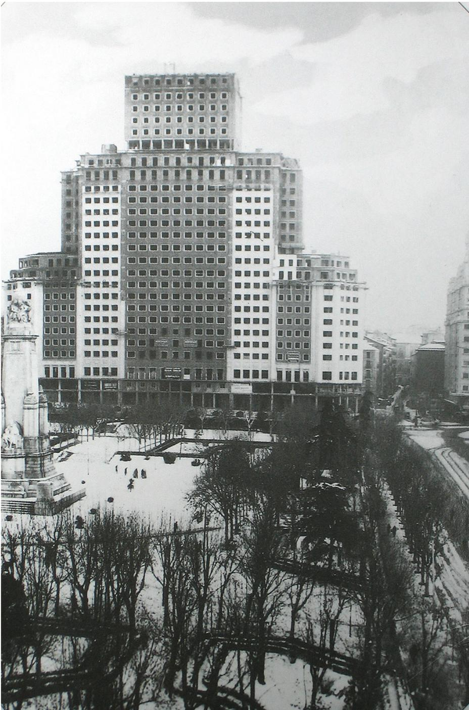
Fig. 33- El Edificio España hacia 1952, a falta de aplicar los elementos decorativos de pilastras, cornisas, pináculos, etc., así como el revestimiento granítico del basamento con el frontispicio.
