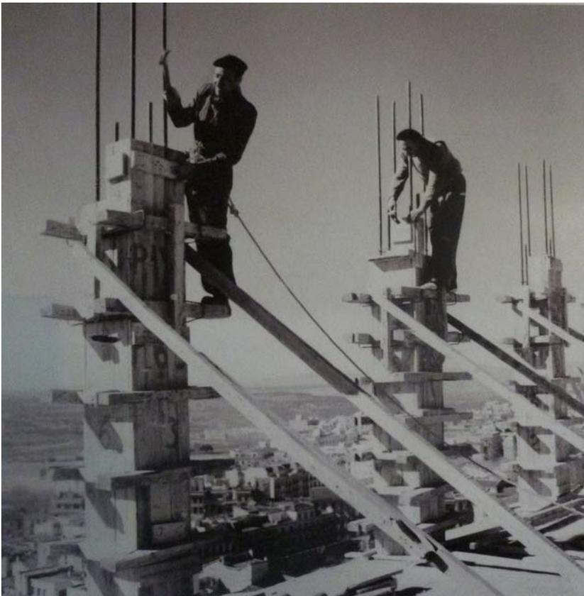
Fig. 31- Encofradores trabajando en los pilares de fachada del edificio España, hacia 1950.
