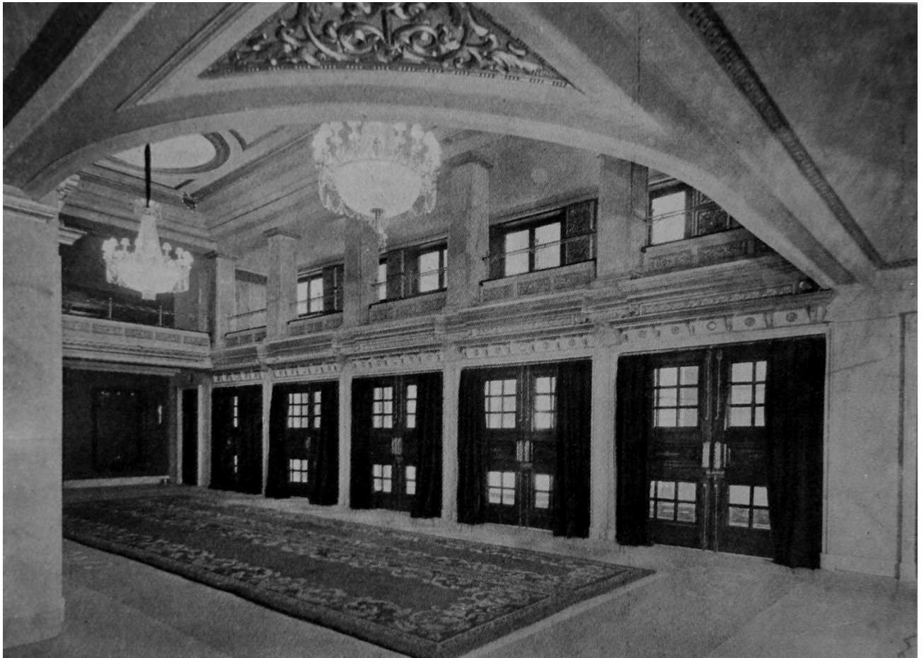
Vestíbulo del teatro Albéniz hacia la entrada. R.N.A. , Año X, nºs 104-105, agosto-septiembre 1950.
