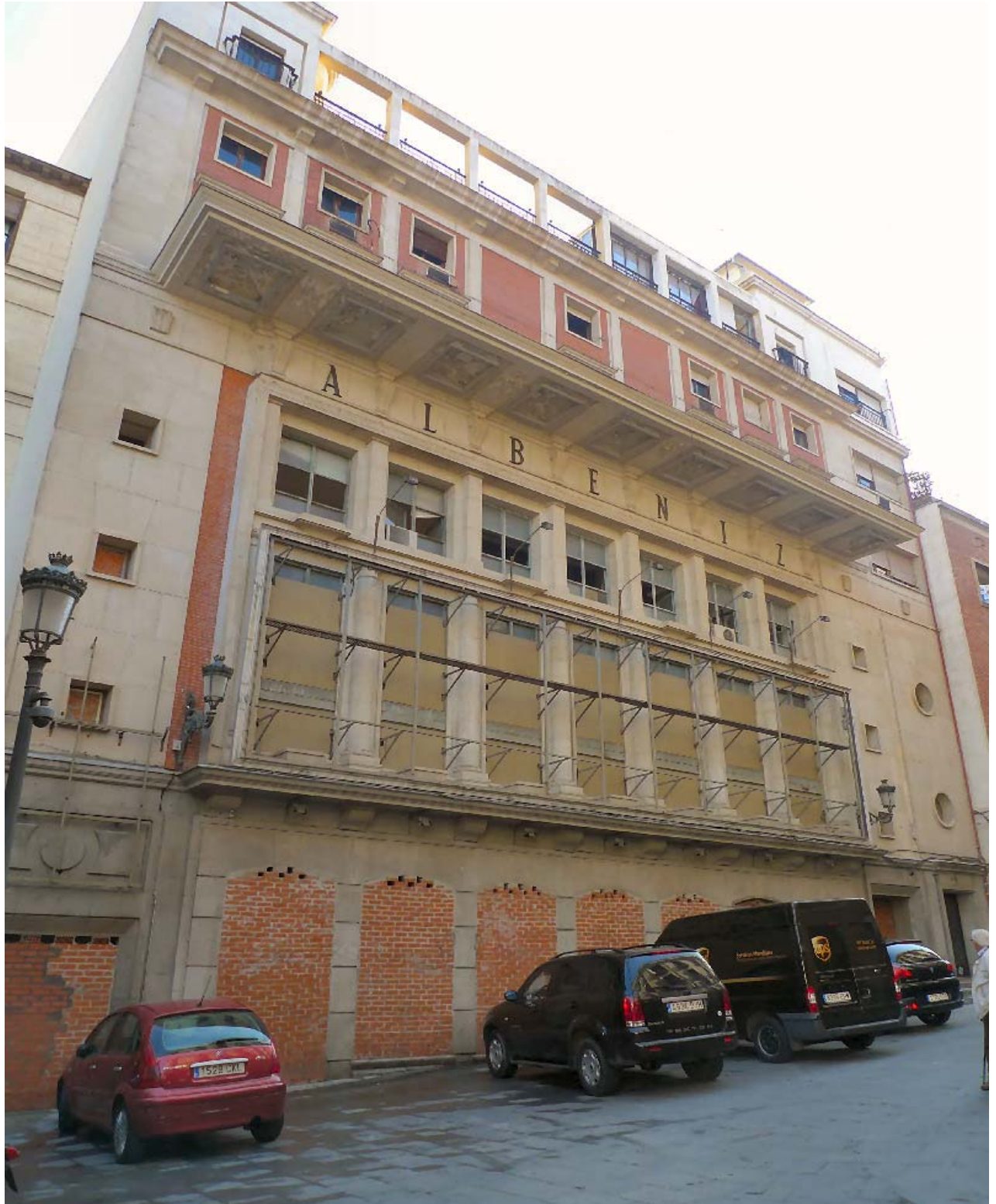
Estado actual de la fachada del Teatro Albéniz. Foto VPAT.
