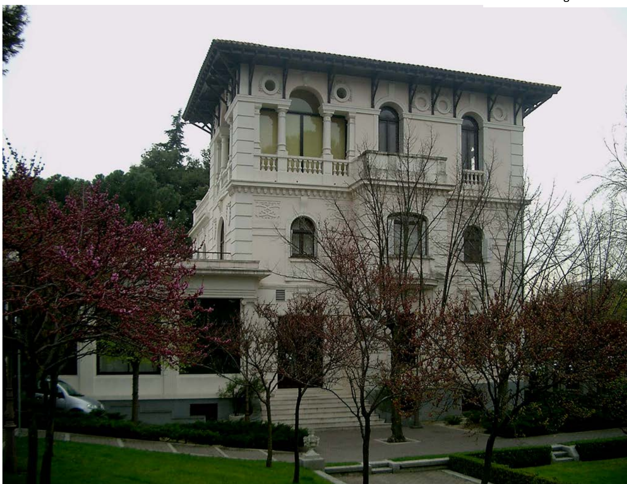
Fachada trasera de Villa Rosa en la actualidad. Fotografía: VPAT.
