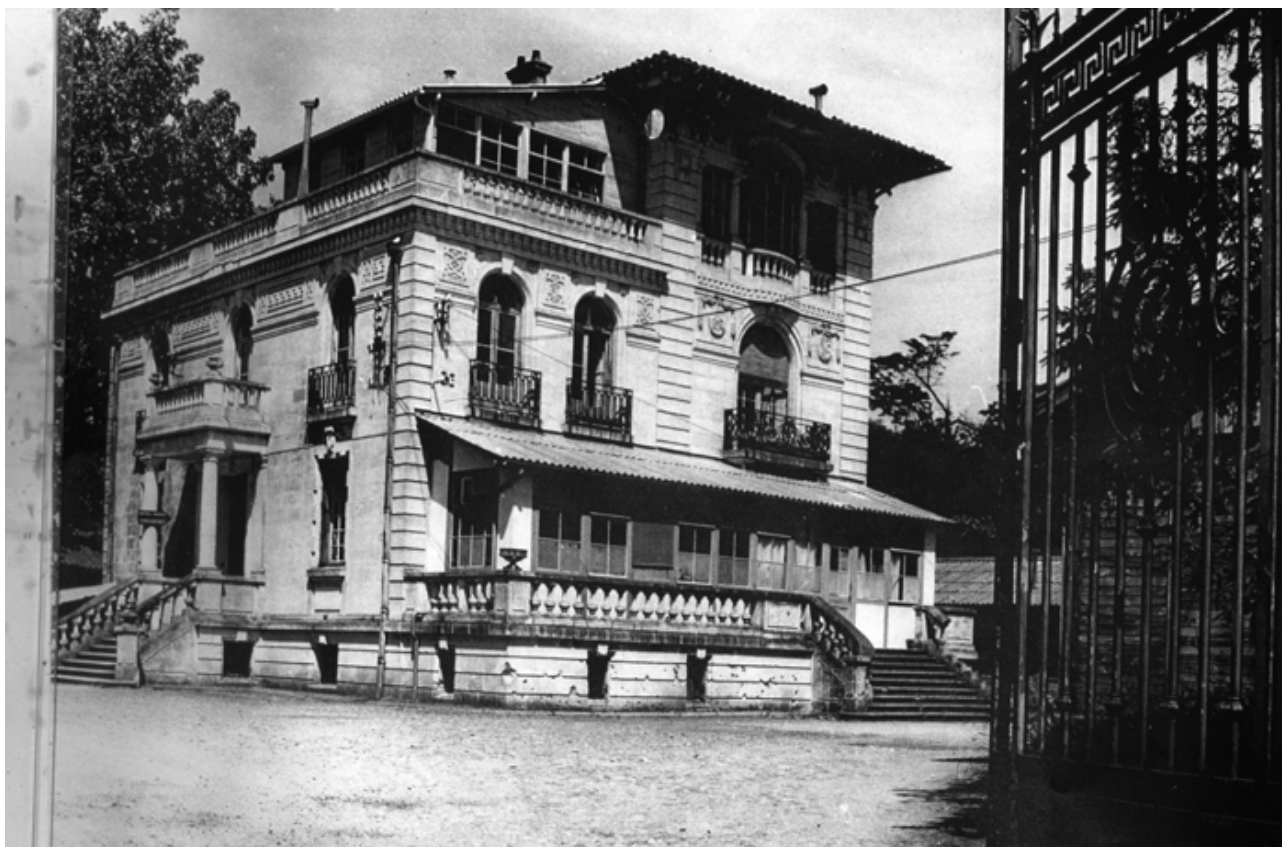
Villa Marquissette hacia 1965, con los añadidos construidos sobre las terrazas. Fotografía: Frédéric Chasseboeuf.
