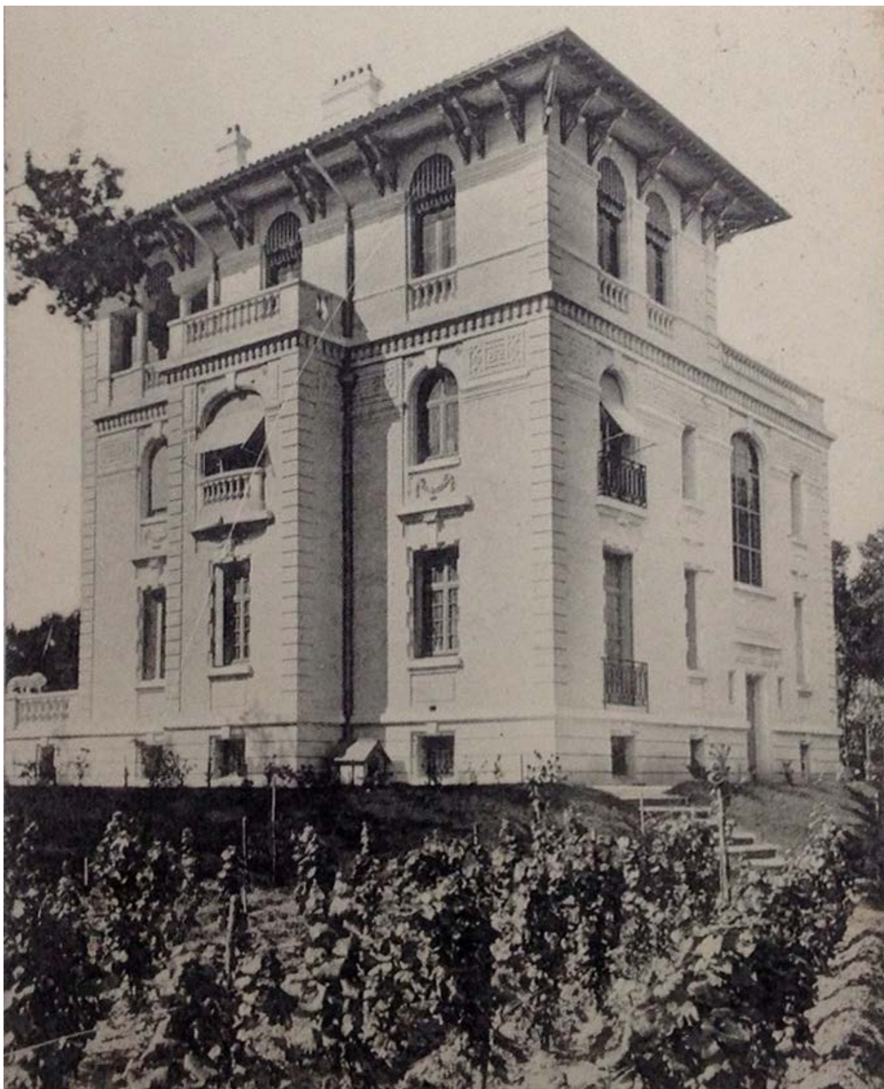
Vista de las fachadas trasera y lateral de Villa Marquissette hacia 1913 en una postal de época.
