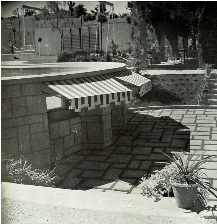
Detalle de la terraza descubierta de la nueva piscina de Villa Rosa, con los ventanales que permitían ver el fondo del vaso de natación. Informes de la Construcción , nº 63, agosto-septiembre de 1954.
