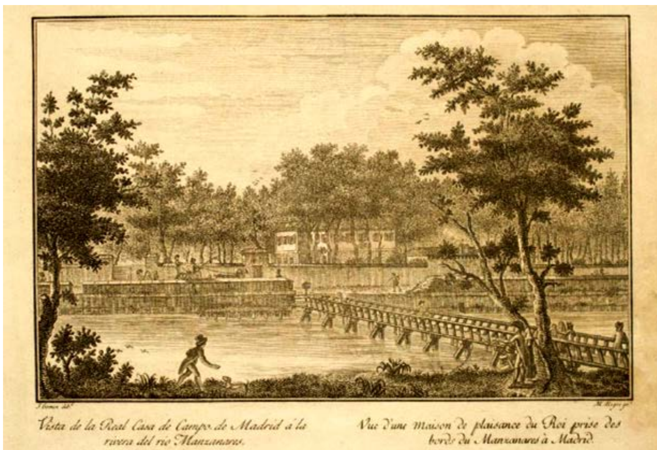
Fig. 20- J. Gómez (dib.) y M. Alegre (grab.): Vista de la Real Casa de Campo de Madrid a la ribera del Manzanares, h. 1815.
