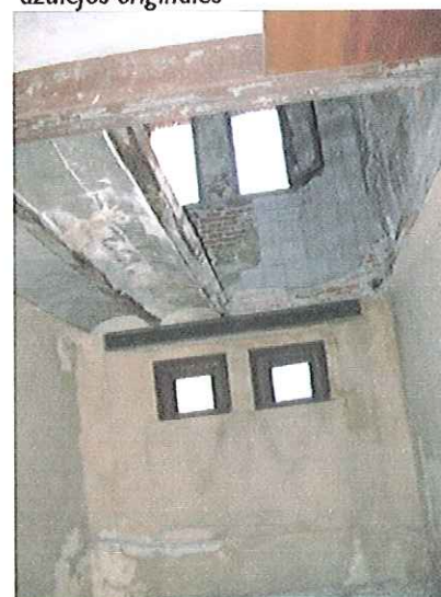
Forjado eliminado entre la segunda y la tercera planta
