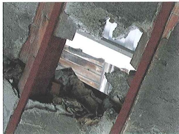
Detalle de los revoltones degradados
