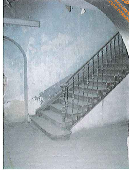
Arranque de la escalera principal
