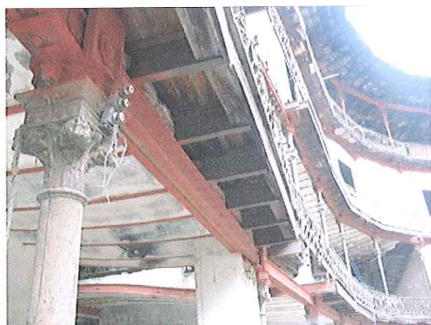
Cielorraso desaparecido en el voladizo del piso primero
