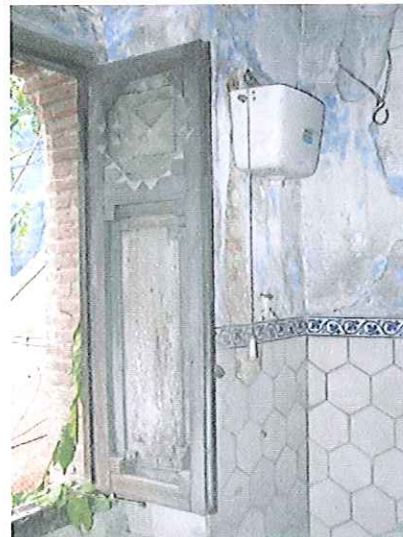
Detalle de carpintería de ventanas y azulejos originales
