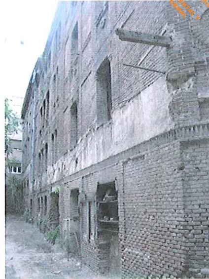
Vista de la cara norte con huellas de construcciones adosadas
