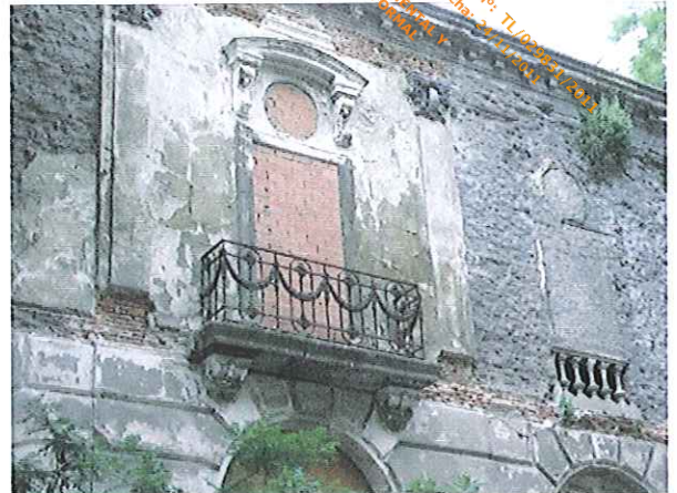
Parcheado con cemento de los revocos originales
