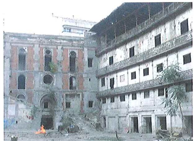
Encuentro de la fachada neomudéjar con el graderío
