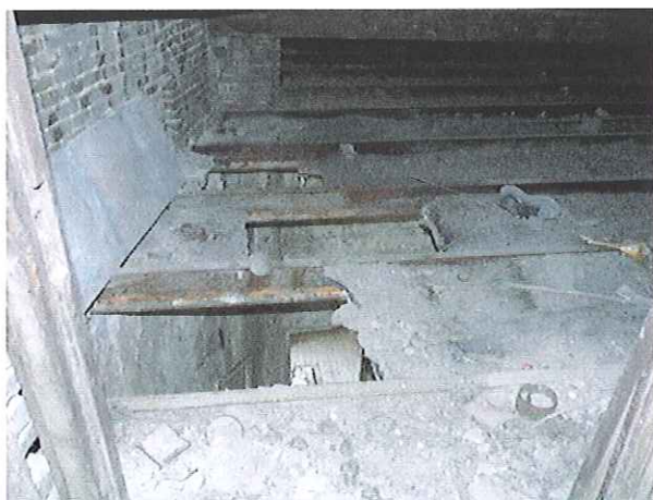
Forjado del tercer piso del edificio principal
