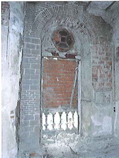
Interior de una ventana de la fachada principal
