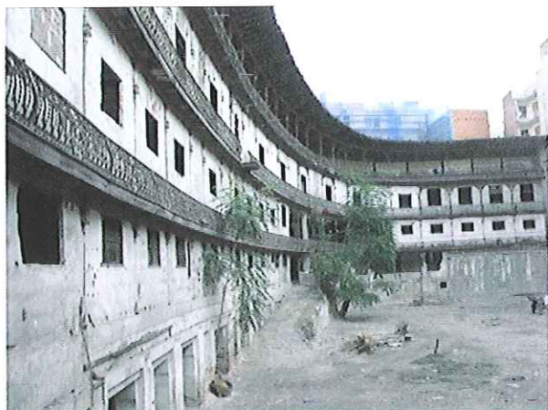
Vista general del graderío tapiado
