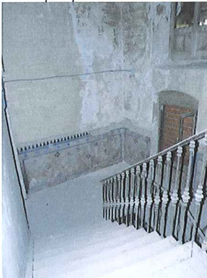
Zócalo de azulejos afectado por la humedad en la escalera principal
