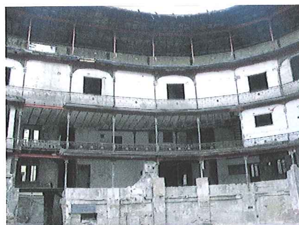
Fragmento del graderío con las galerías abiertas originales
