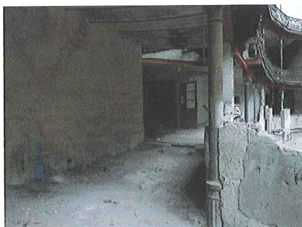
Cielorraso desaparecido en el voladizo del piso primero
