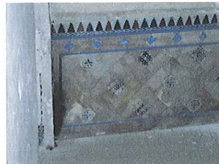
Detalles de azulejos, y de barandillas reaprovechadas del graderío para proteger un hueco abierto en el forjado original
