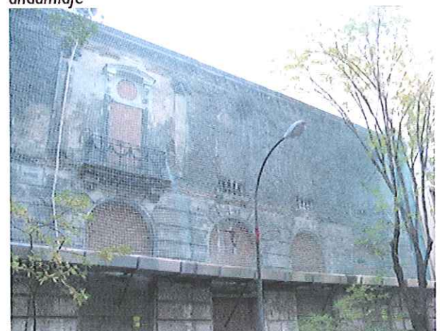
Las mallas que envuelven la fachada en su estado actual
