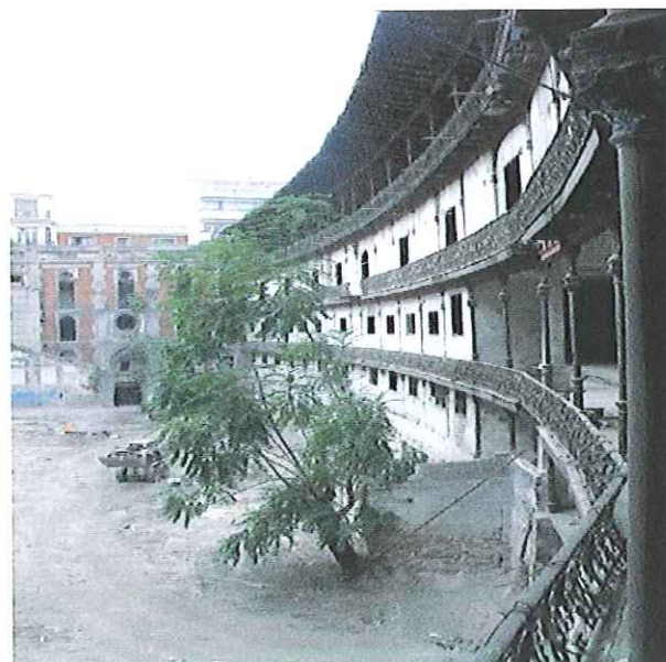
Perspectiva del graderío desde la parte abierta
