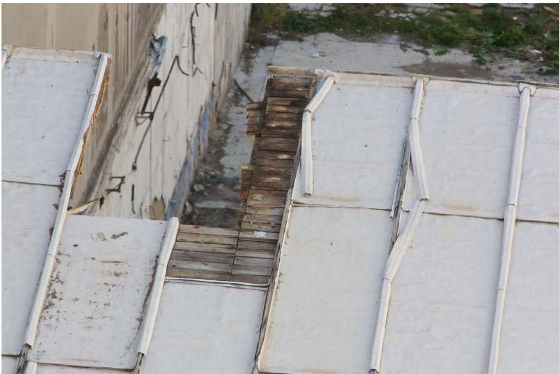
Cortes con motosierra de la tablazón de la cubierta del graderío.
