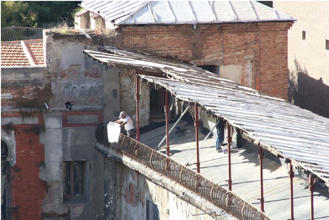
Operario arrojando escombros desde el graderío superior. Alero recortado a máquina.
