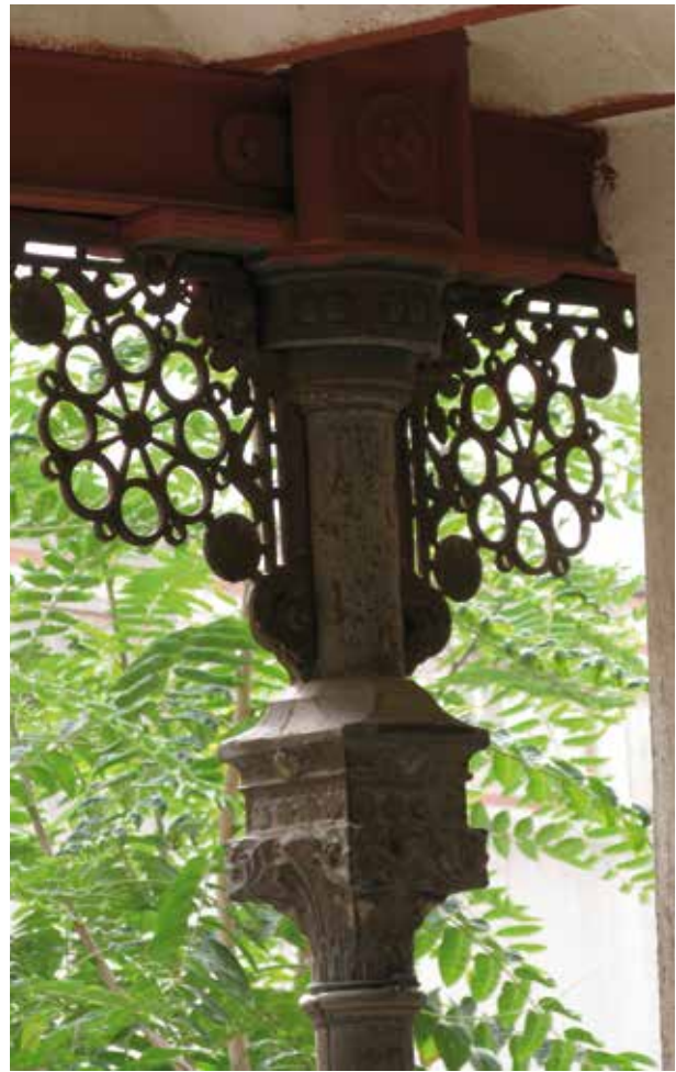
Detalle de las columnas de hierro fundido. Igor González.
