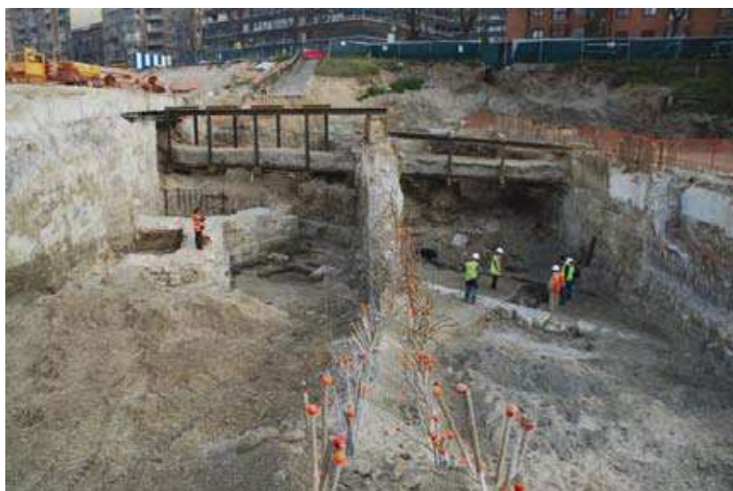
Restos de la cabecera del Real Canal del Manzanares, descubiertos durante las obras de soterramiento de la M-30, en 2006.
