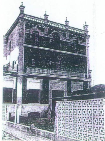
FACHADA LATERAL NORESTE
