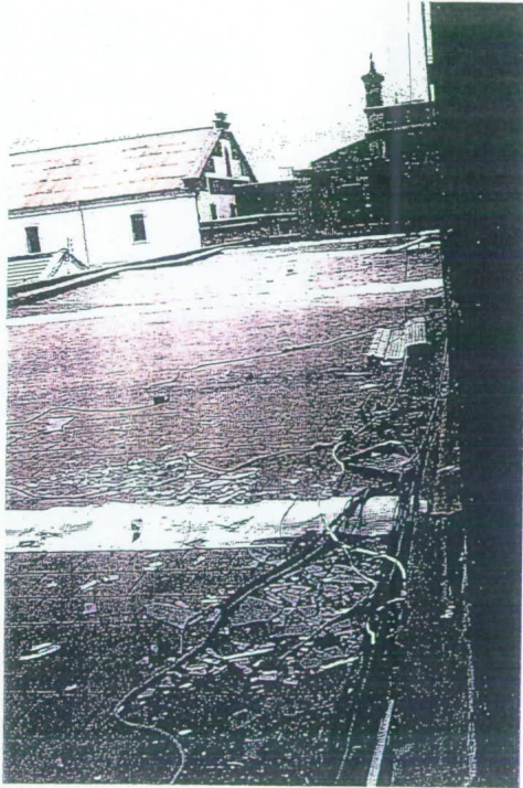
VISTA DE LA CUBIERTA DEL COMEDOR (CUERPO ADOSADO)
