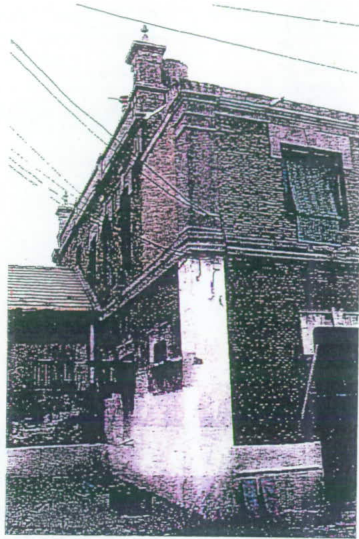
VISTA DE LA ESQUINA SUROESTE DEL EDIFICIO
