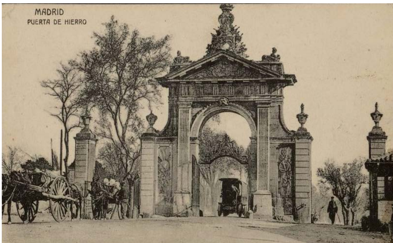
Fig. 152- La histórica Puerta de Hierro en su ubicación original según una postal antigua.
