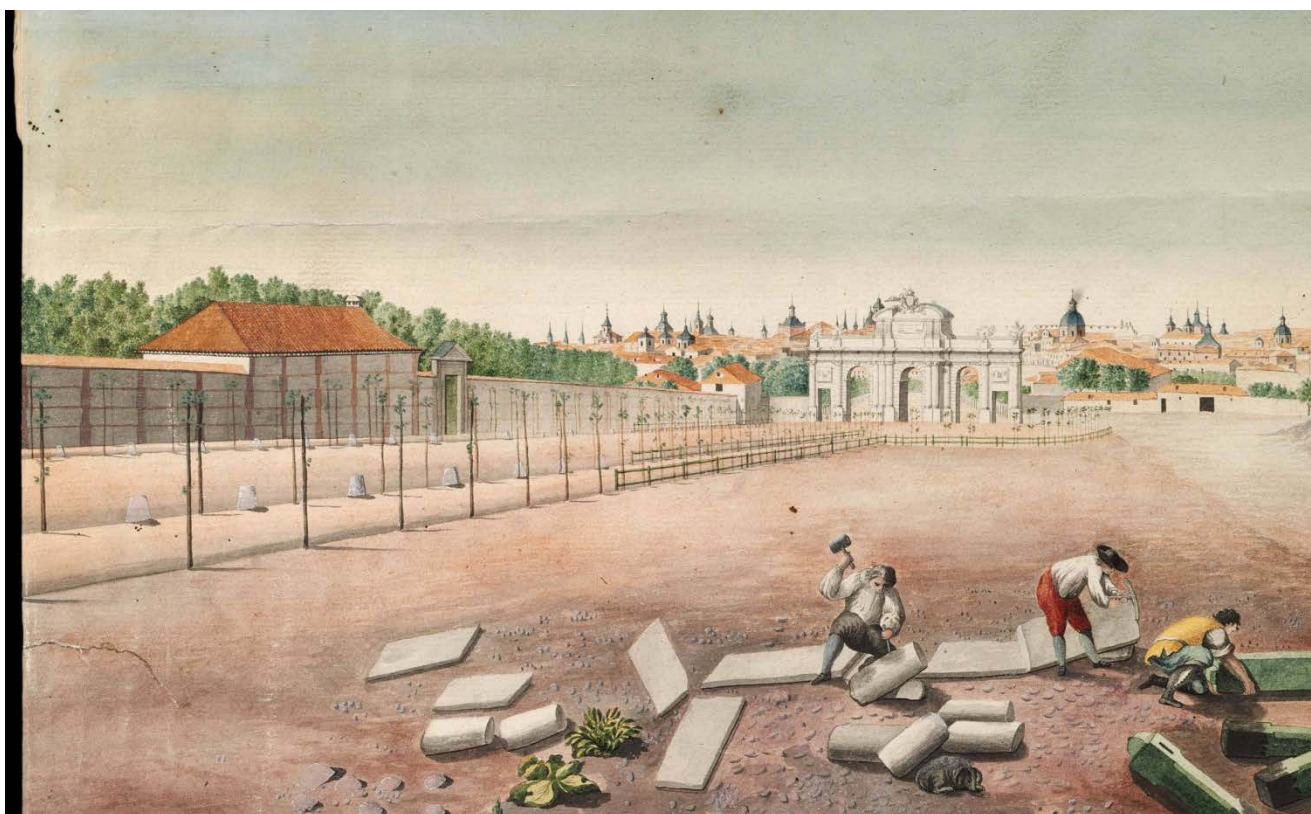
Fig. 13- Detalle del anterior donde se aprecia la tapia nueva ejecutada con aparejo toledano (con "cajas" de mampostería entre hiladas y "cadenas" de ladrillo), y la nueva Puerta Verde coronada por un frontón.
