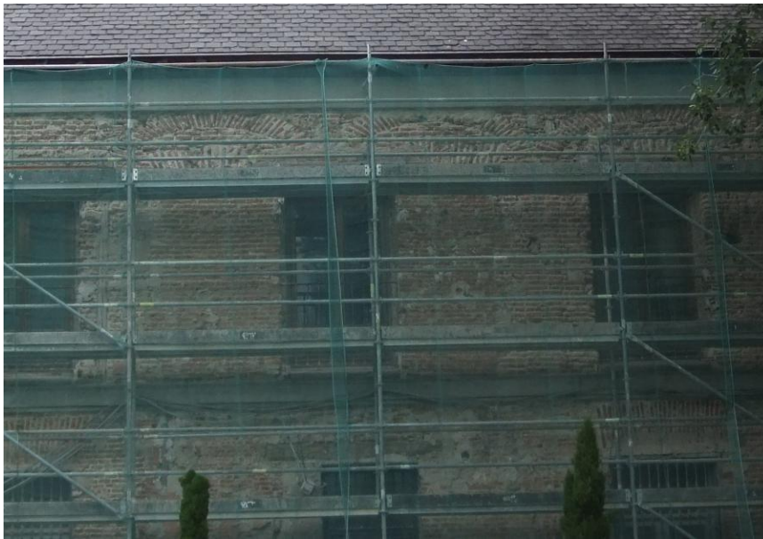
Restauración de fachadas de 2014. Fachada sur del palacio. Bajo el revoco aparecieron restos de la galería renacentista.
