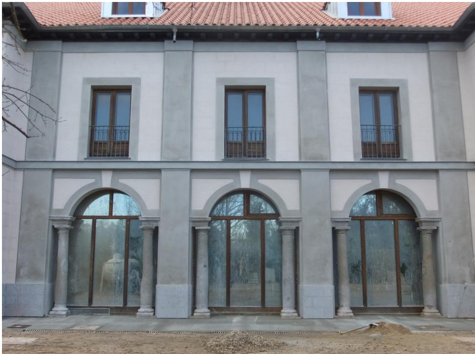
Pórtico de la fachada norte con columnas reutilizadas del primitivo palacio. Foto del autor
